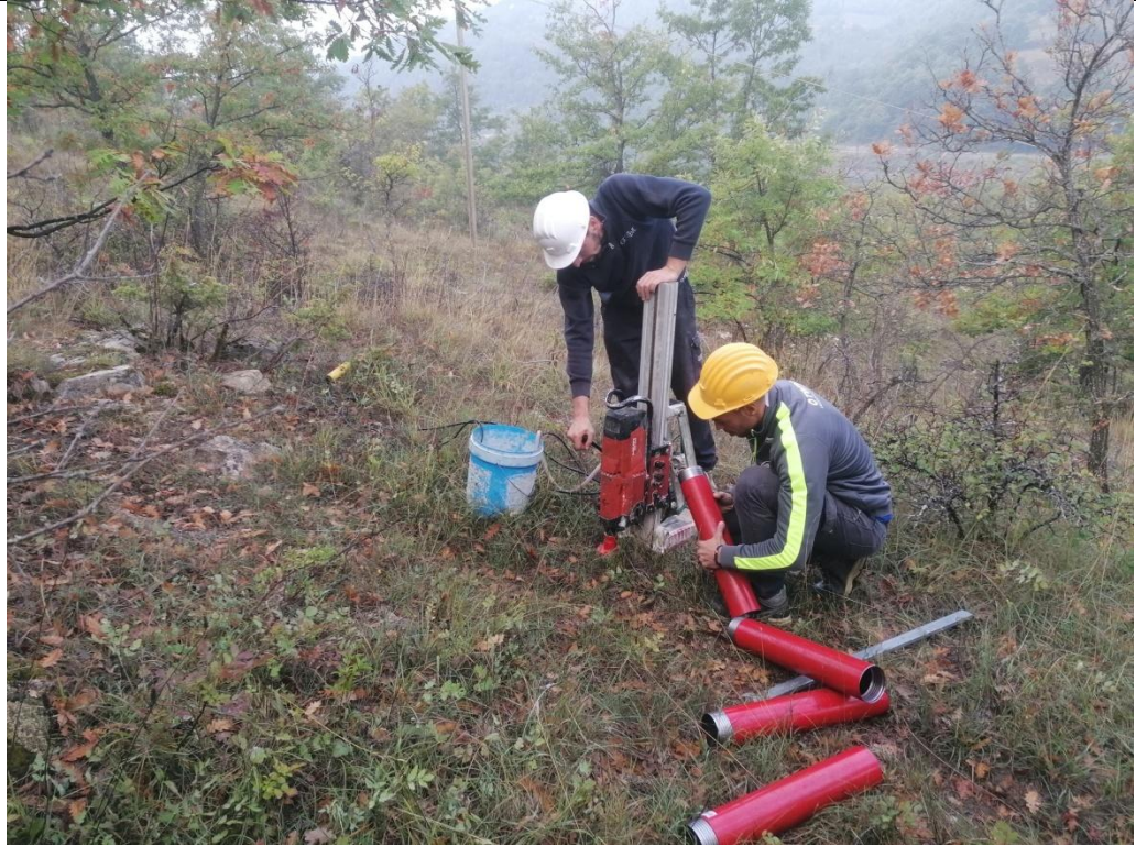
Esecuzione carotaggio P.6G
