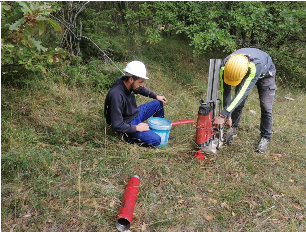
Esecuzione carotaggio P. 6H
