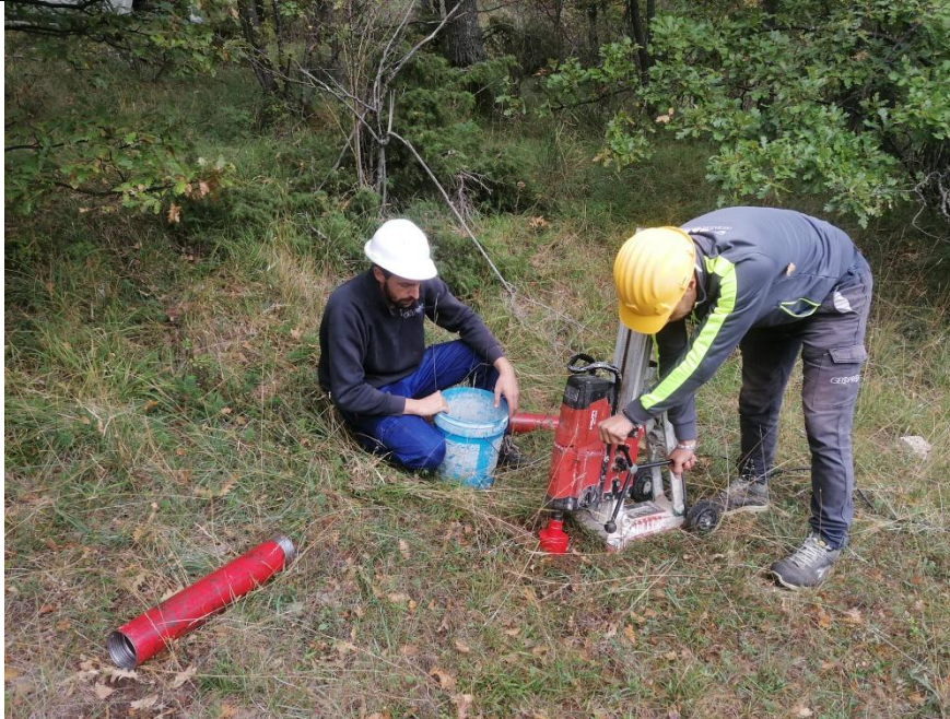
Esecuzione carotaggio P. 6H
