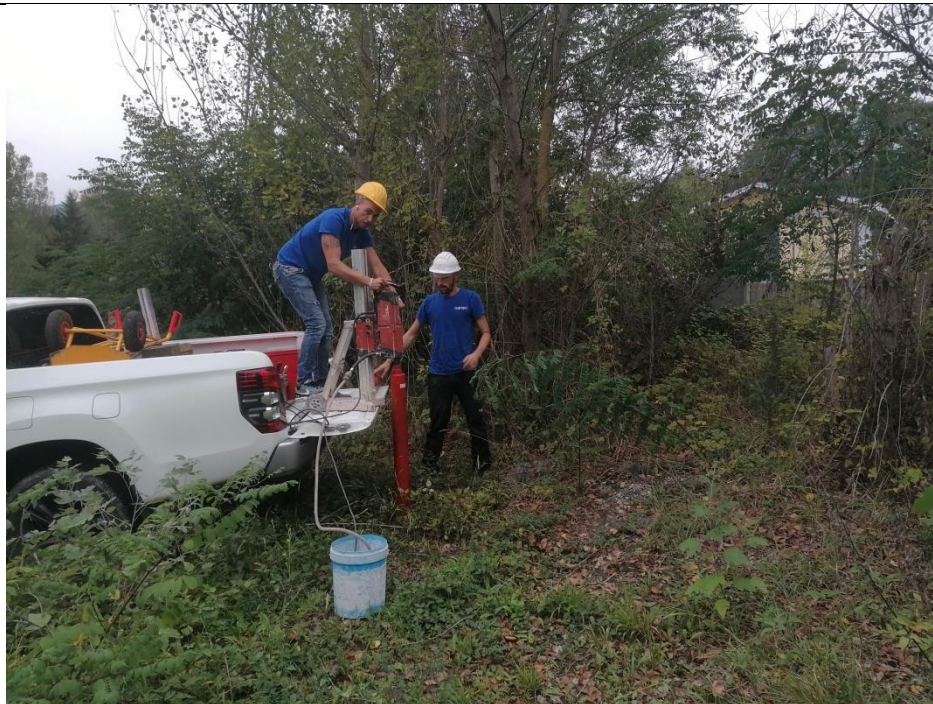
Esecuzione carotaggio P.76
