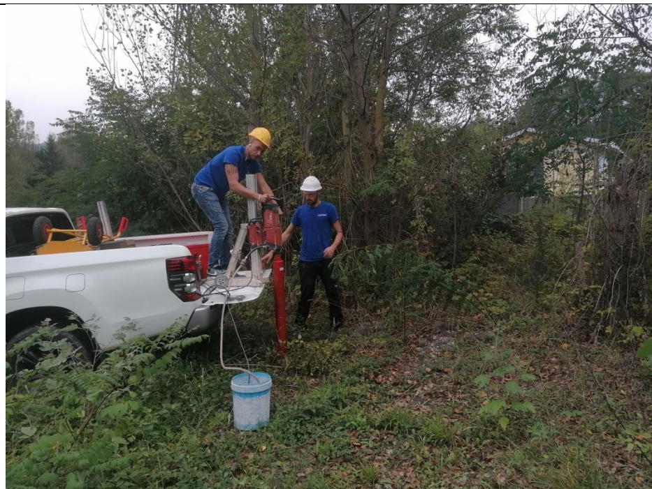
Esecuzione carotaggio P.76
