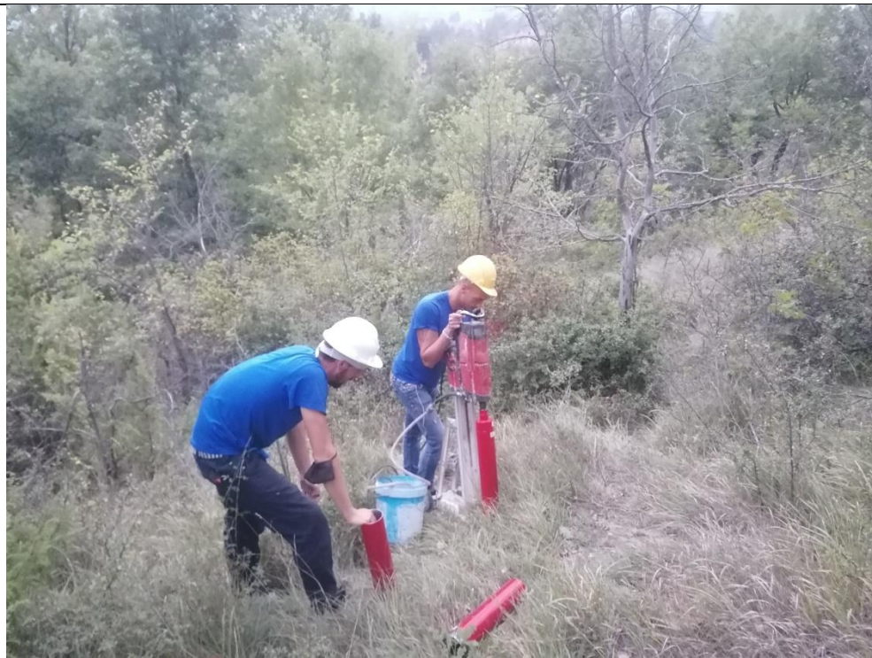
Esecuzione carotaggio P.78
