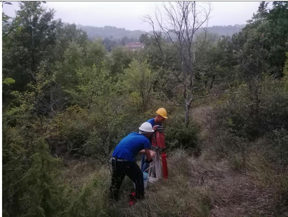
Esecuzione carotaggio P.78
