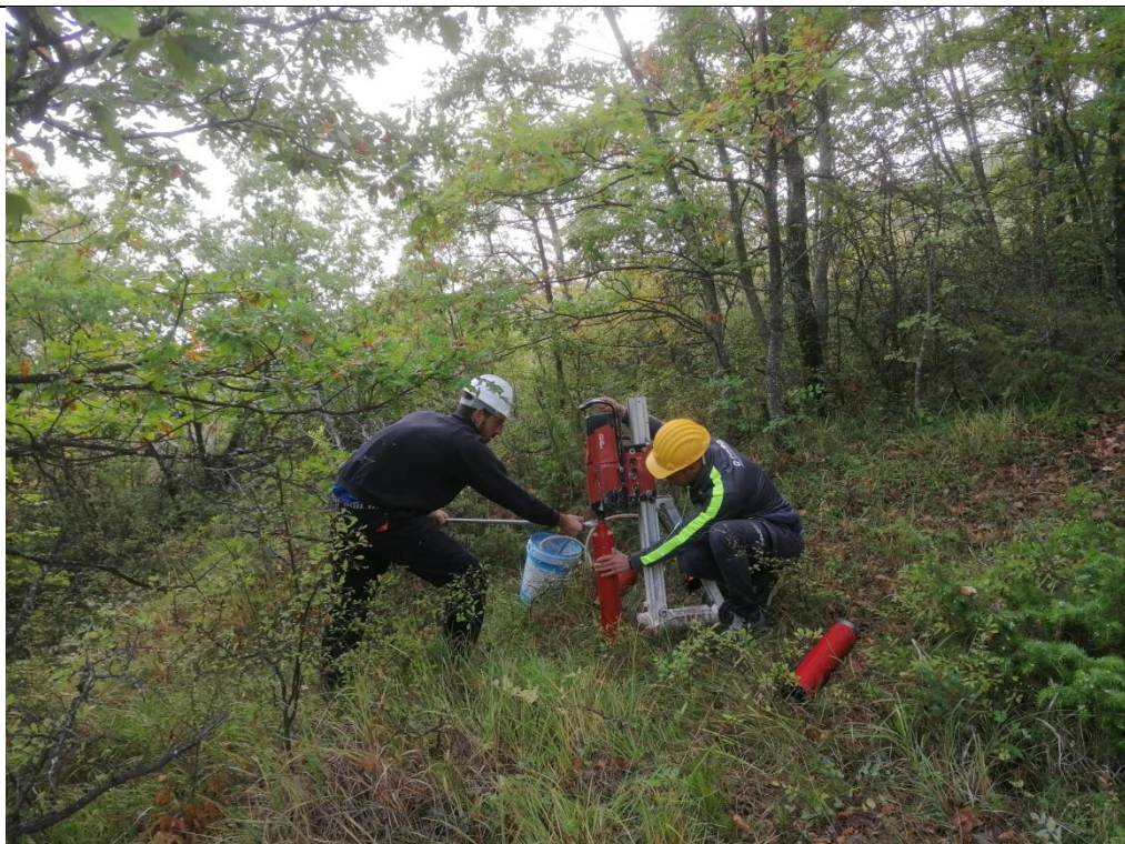
Esecuzione carotaggio P.79
