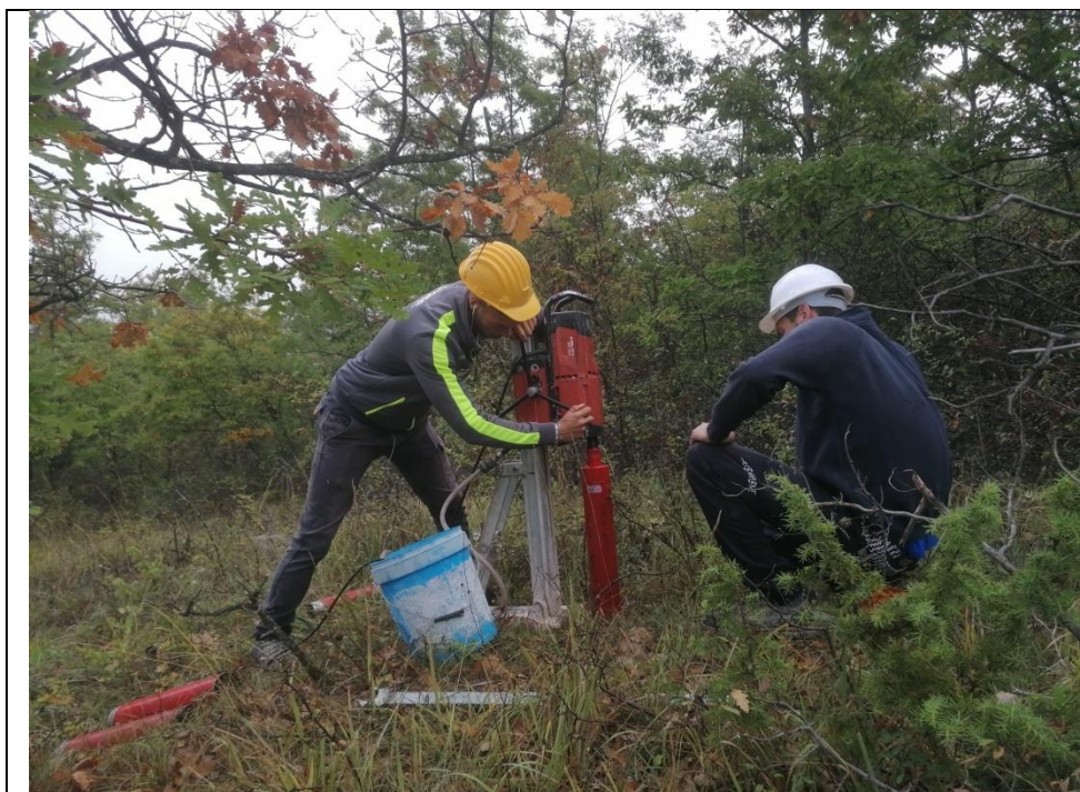
Esecuzione carotaggio P.7G
