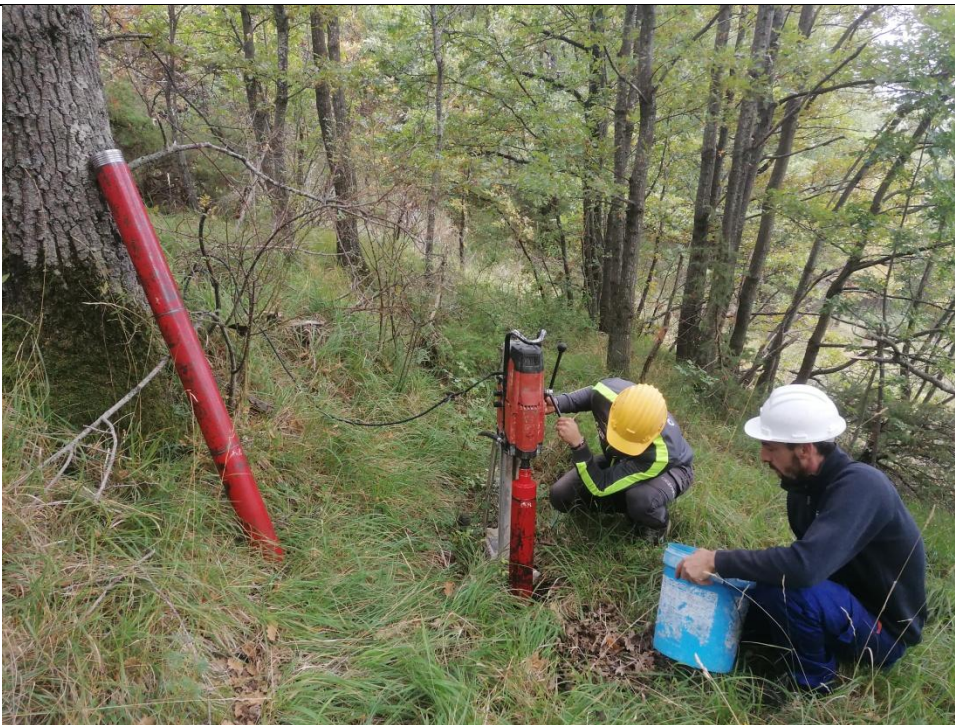
Esecuzione carotaggio P. 7H
