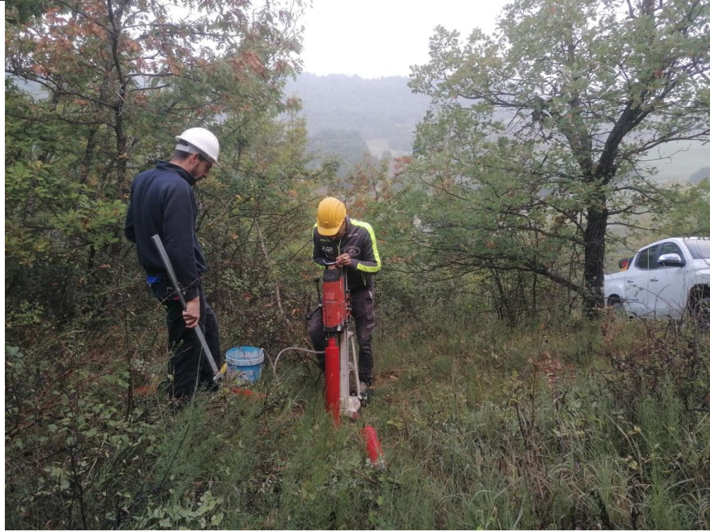
Esecuzione carotaggio P.80
