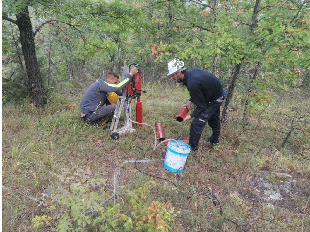
Esecuzione carotaggio P.81
