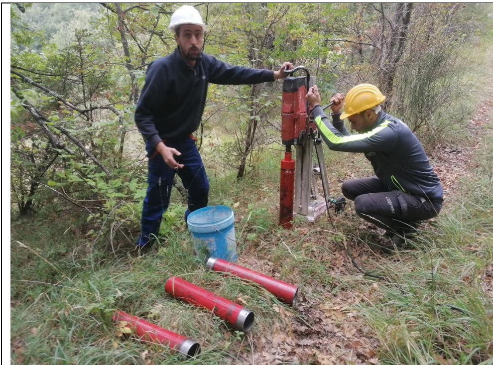
Esecuzione carotaggio P. 9H
