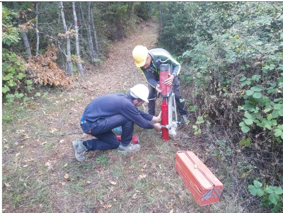
Esecuzione carotaggio P. PBG
