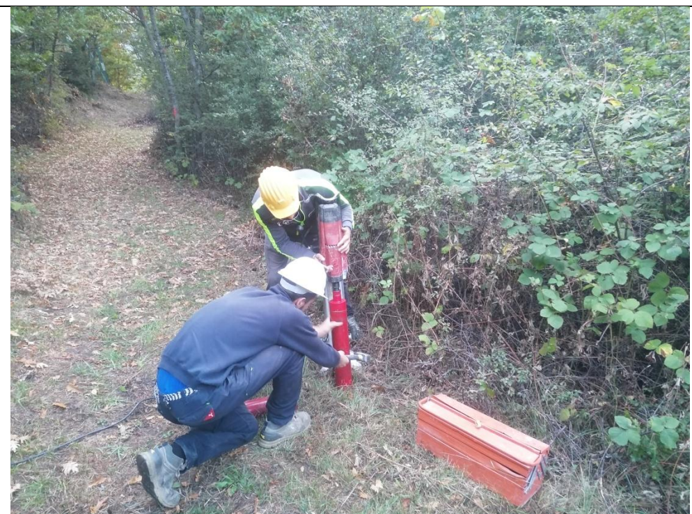
Esecuzione carotaggio P. PBG
