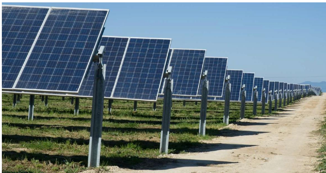
Figura 5 - immagine esemplificativa di inseguitori mono-assiali in configurazione 1P (fonte: ConvertItalia)
