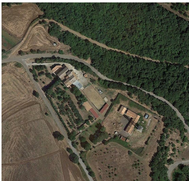
Fig. 4.3 Fabbricati a est dell'area di intervento
