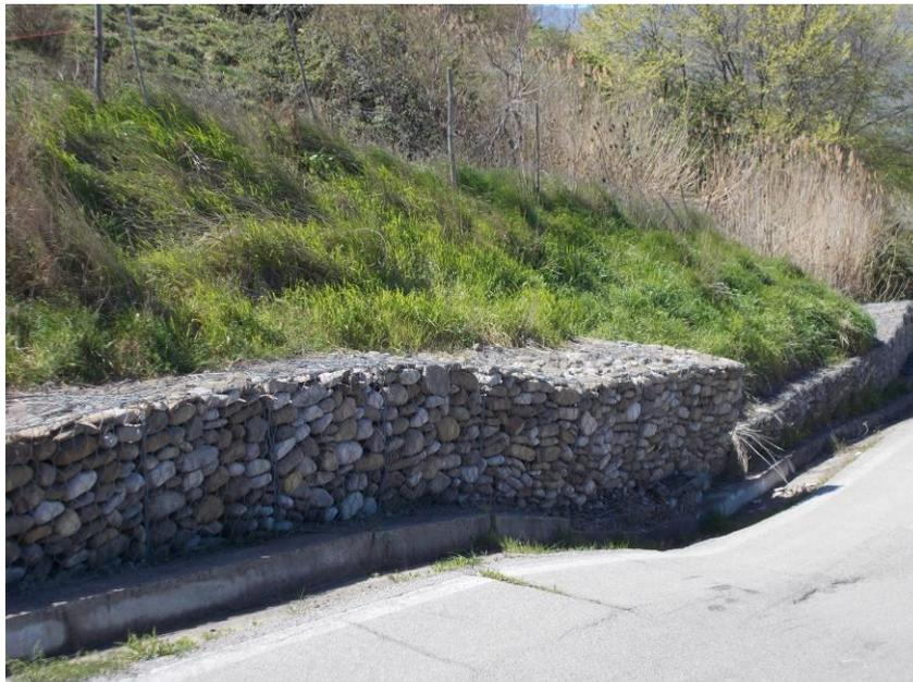
Foto G - Deformazioni delle gabbionate e della sede stradale
