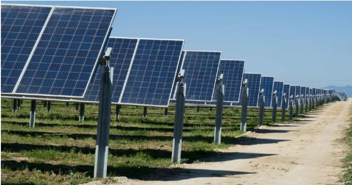
Fig. 2.4 – Immagine esemplificativa di inseguitori mono-assiali e moduli FV
