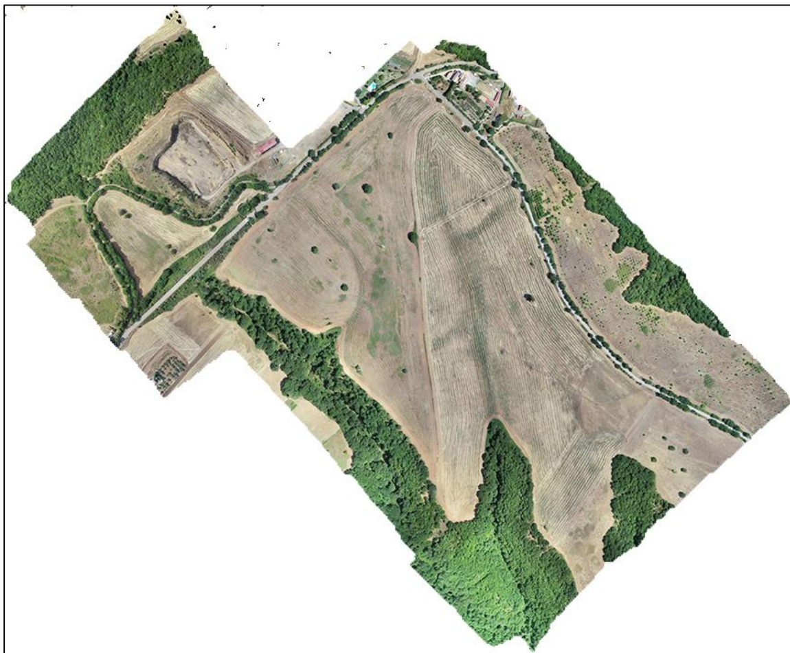
Fig. 2.2 – Ortofoto dell’area d’intervento
