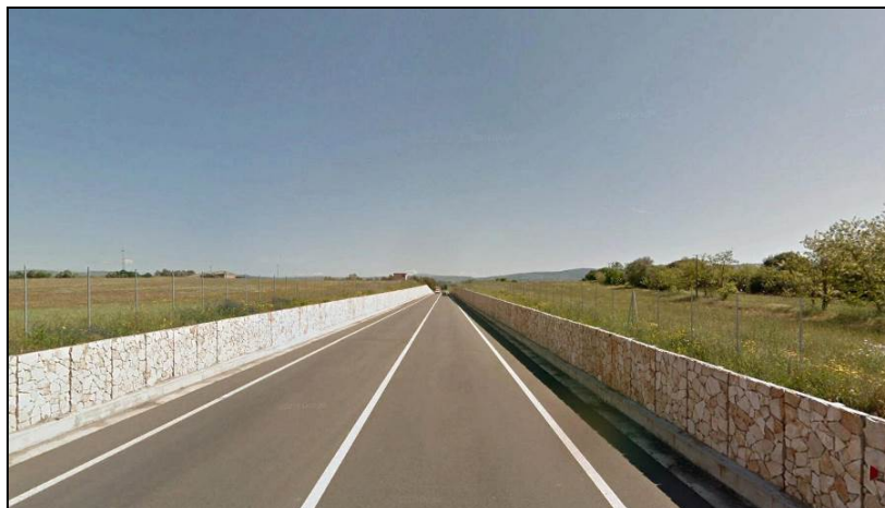
Figura. Tratto esistente adeguato tra muri.
