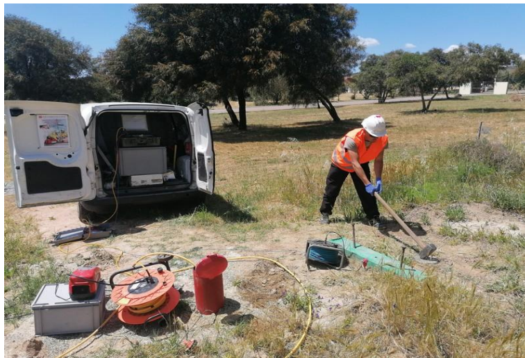
Fase acquisizione onde "P"
