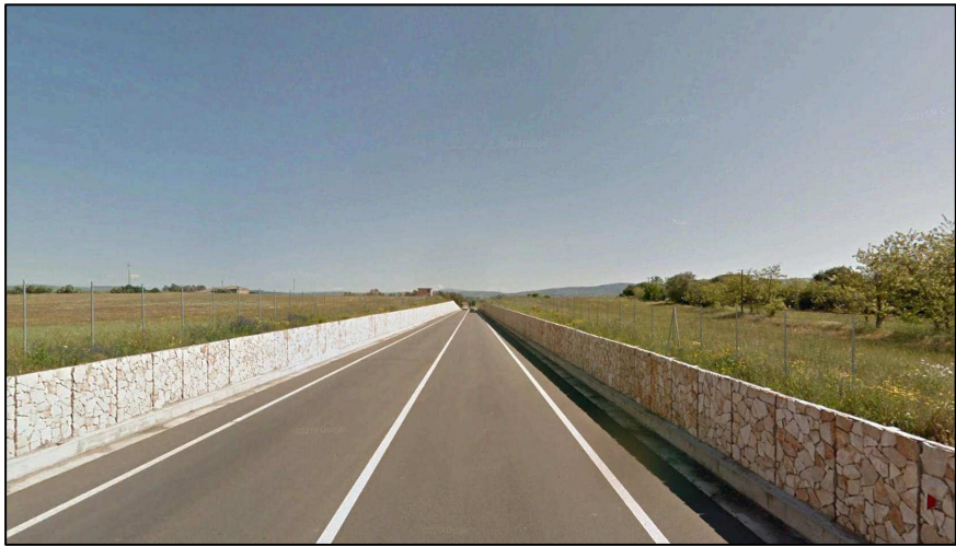
Figura 7. Tratto esistente adeguato tra muri.
