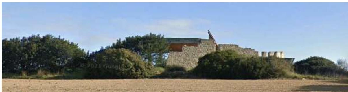
Figura 3-86 Chiesa dei Santi Bertorio, Giustino e Fedele in corrispondenza della pk 7+950 nel Comune di Samatzai (Fonte:Google Earth)
