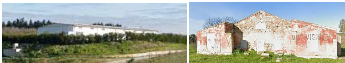
Figura 3-84 Sistema insediativo di Samatzai: a sinistra l'azienda avicola Mudu e a destra un fabbricato rurale in stato di rudere (Fonte:Google Earth)
