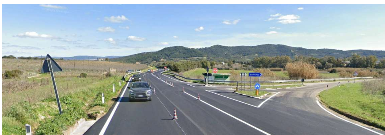
Figura 3-89 Strada statale SS 128 in corrispondenza della rotonda di progetto (ROT_04) nel Comune di Barrali (Fonte:Google Earth)
