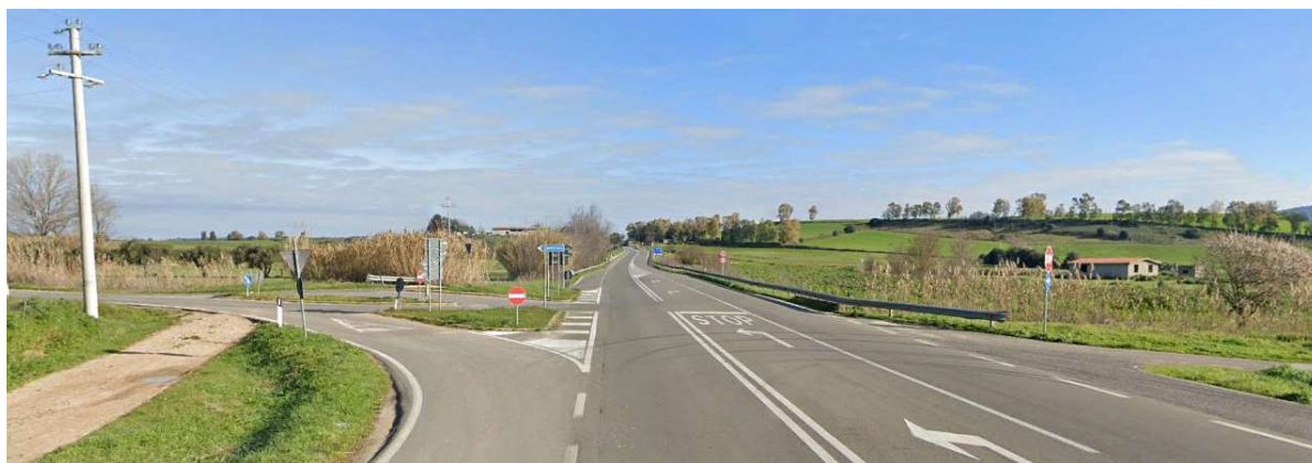
Figura 3-87 Asse secondario in corrispondenza del raccordo con la SP33 nel Comune di Samatzai (Fonte:Google Earth)
