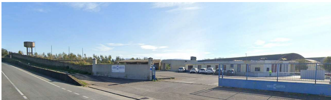
Figura 3-81 Zona industriale Mixeddu (Fonte:Google Earth)
