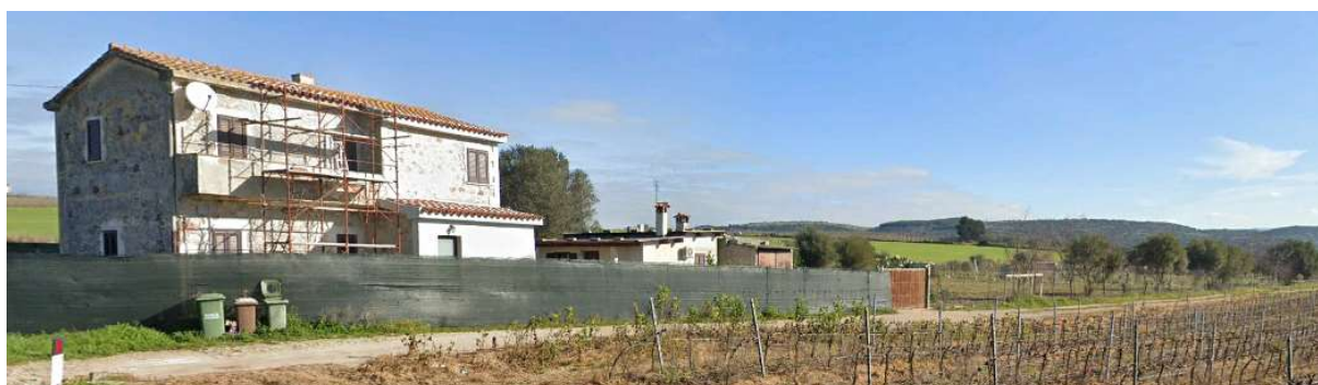
Figura 3-85 Fabbricato rurale in corrispondenza della pk 7+300 nel Comune di Samatzai (Fonte:Google Earth)
