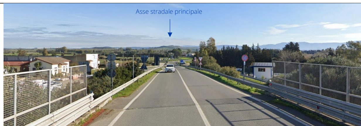
Vista lontana e filtrata dalla SS128 in direzione del tratto oggetto di intervento. La visuale è determinata sul viadotto di attraversamento della SS131 Carlo Felice. In secondo piano è visibile la rotatoria dalla quale ha inizio la tratta oggetto di intervento.
