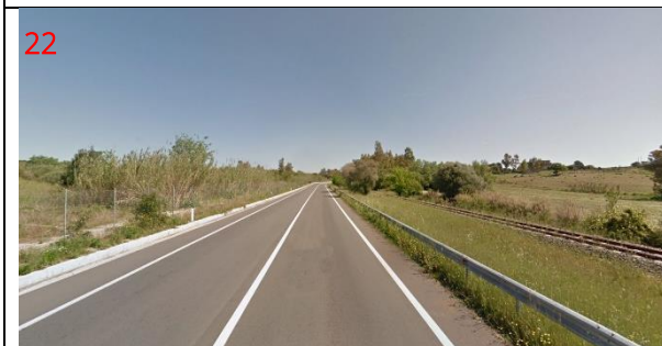
La visuale è determinata lungo la SS128 in direzione nord (Senorbì). L'intervento prevede l'allargamento della sede stradale. A destra dell'immagine si sviluppa la ferrovia Cagliari-Isili.
