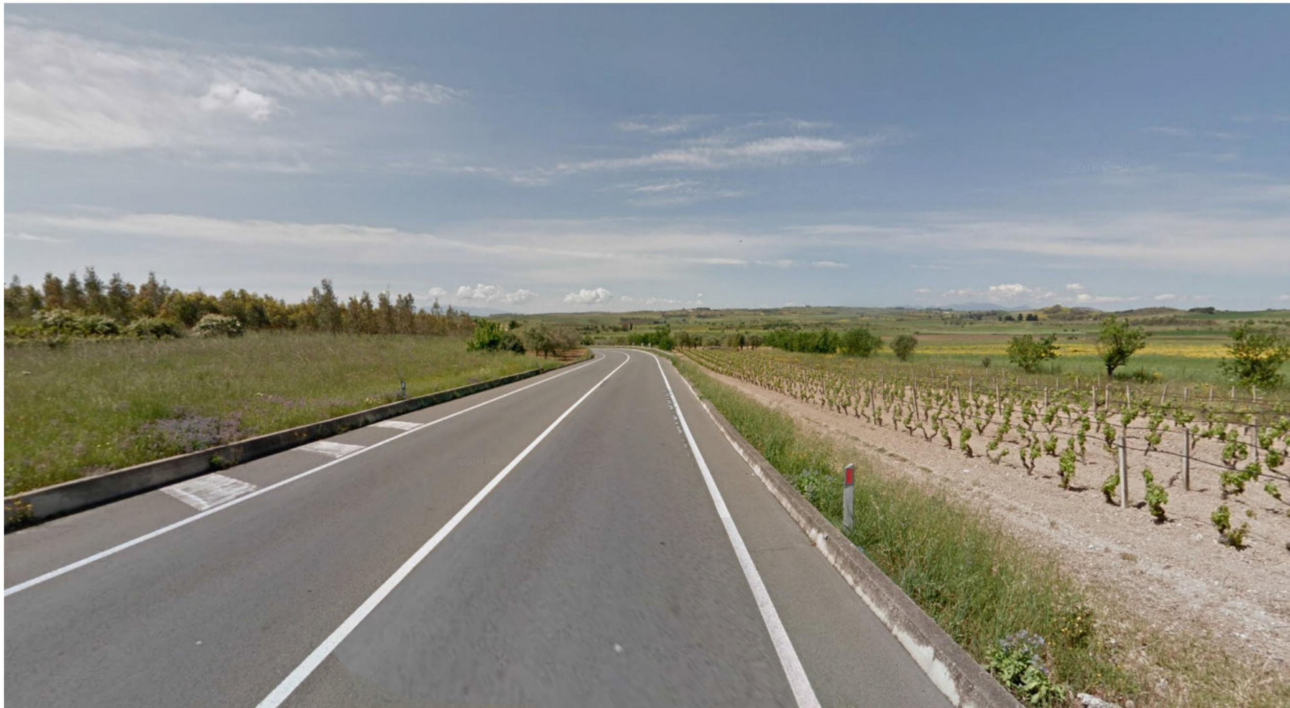
**Punto 17:** La visuale è determinata lungo la SS128, in direzione sud (Samatzai). Nel tratto individuato nella foto, l'intervento prevede l'allargamento della sede stradale e un nuovo raggio di curvatura della strada, che si svilupperà in trincea in corrispondenza delle alberature sulla sinistra della foto. (fonte: Google Maps)
