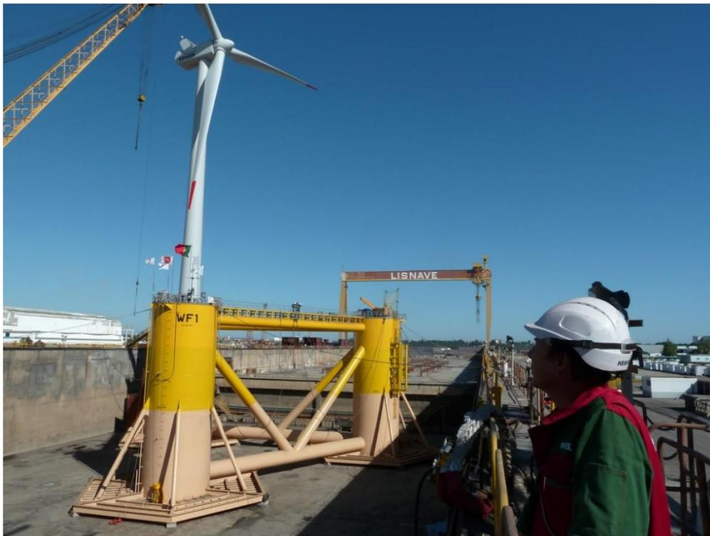
Figura 6-3 - Fasi di assemblaggio della piattaforma galleggiante (Fonte Windfloat Atlantic Project)
