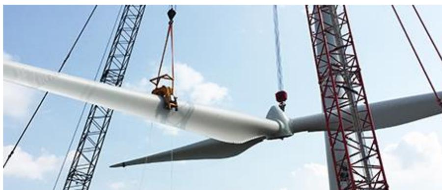
Figura 6-5 - Sollevamento del rotore (Fonte: Elronic Wind solution)
