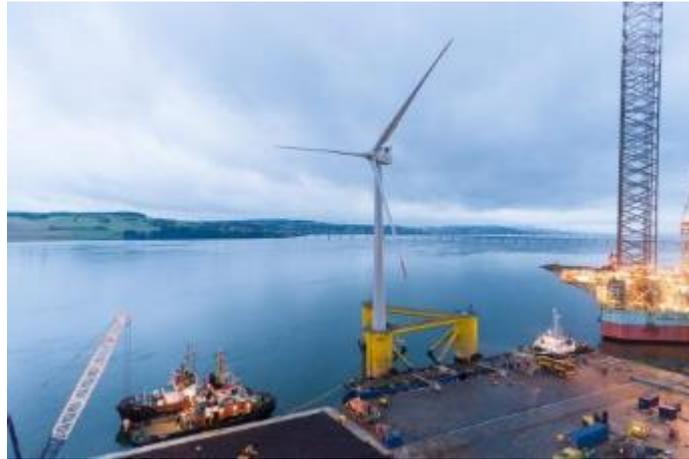
Figura 6-2 - Assemblaggio piattaforma galleggiante (Fonte kinkardine -Cobra)
