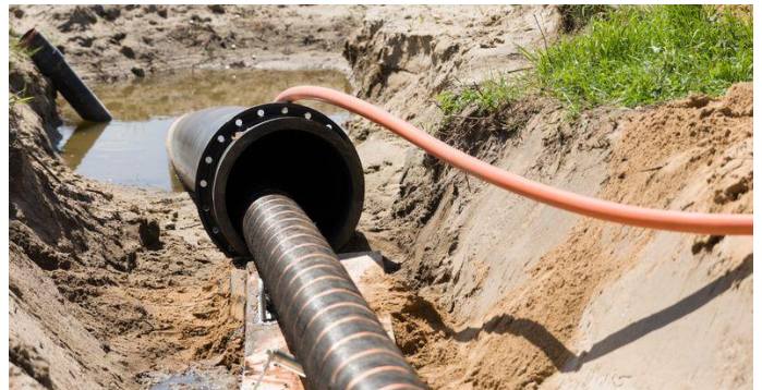
Figura 22 - Esempio di tubazione di protezione all'arrivo a terra - NKT Cables
