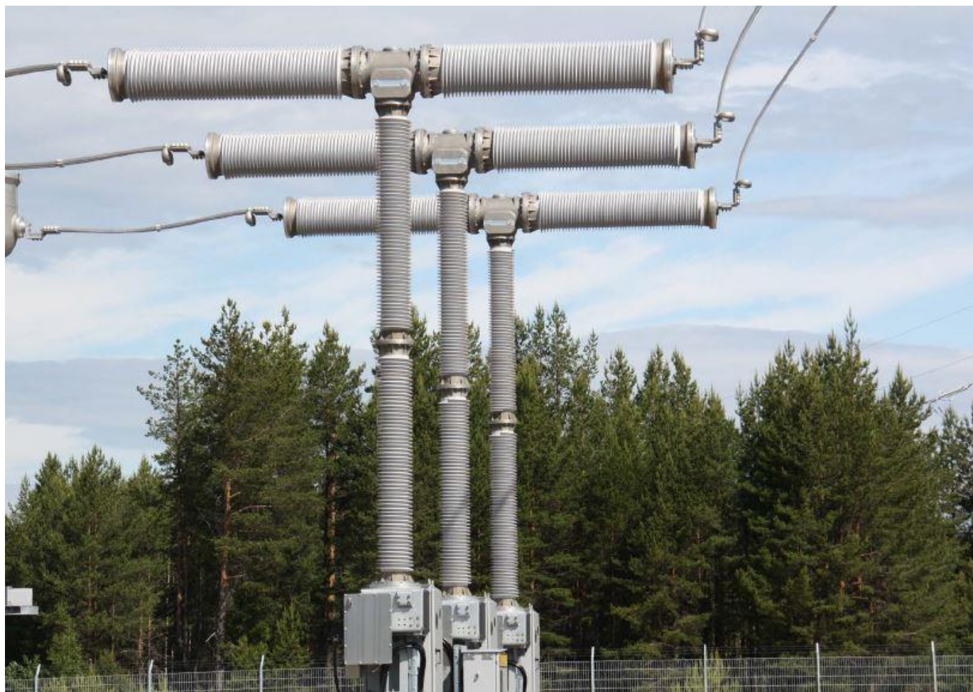
Figura 30 - interruttore 420kV (fonte Siemens)
