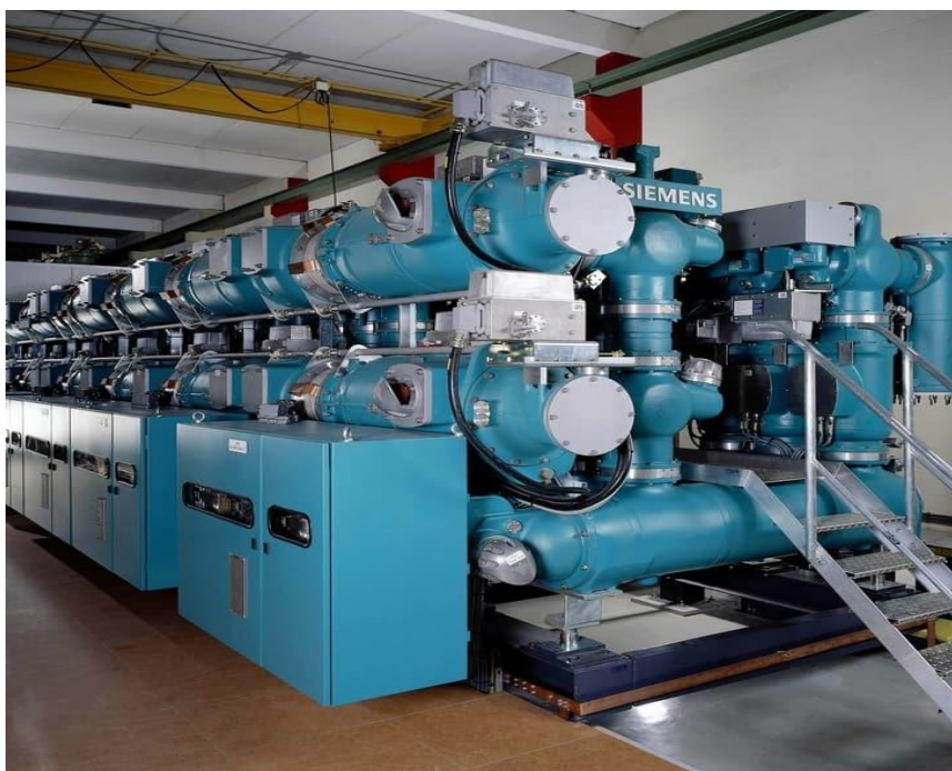
Figura 18 - Celle AT 380kV in stazione Off-shore (fonte Siemens)
