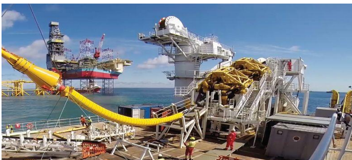
Figura 23 - Particolare dell'imbarcazione posa cavi - NKT Cables
