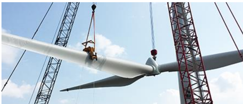
Figura 2.BB Sollevamento del rotore (Fonte: Elronic Wind solution)
