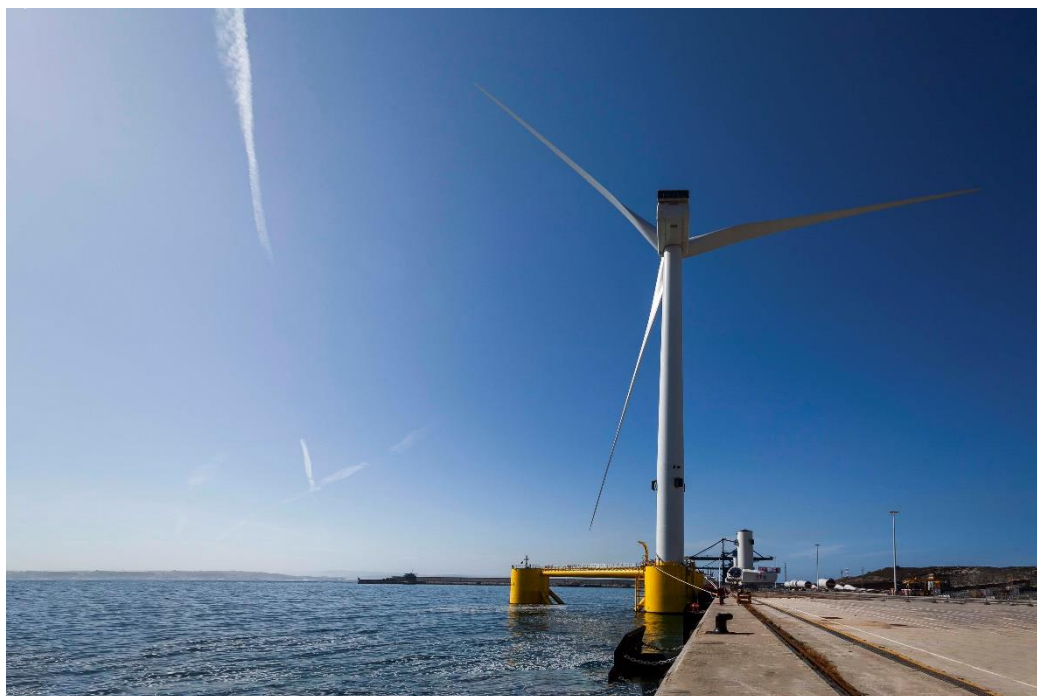
Figura 2.AA Fasi di assemblaggio della piattaforma galleggiante (Fonte Windfloat Atlantic Project)
