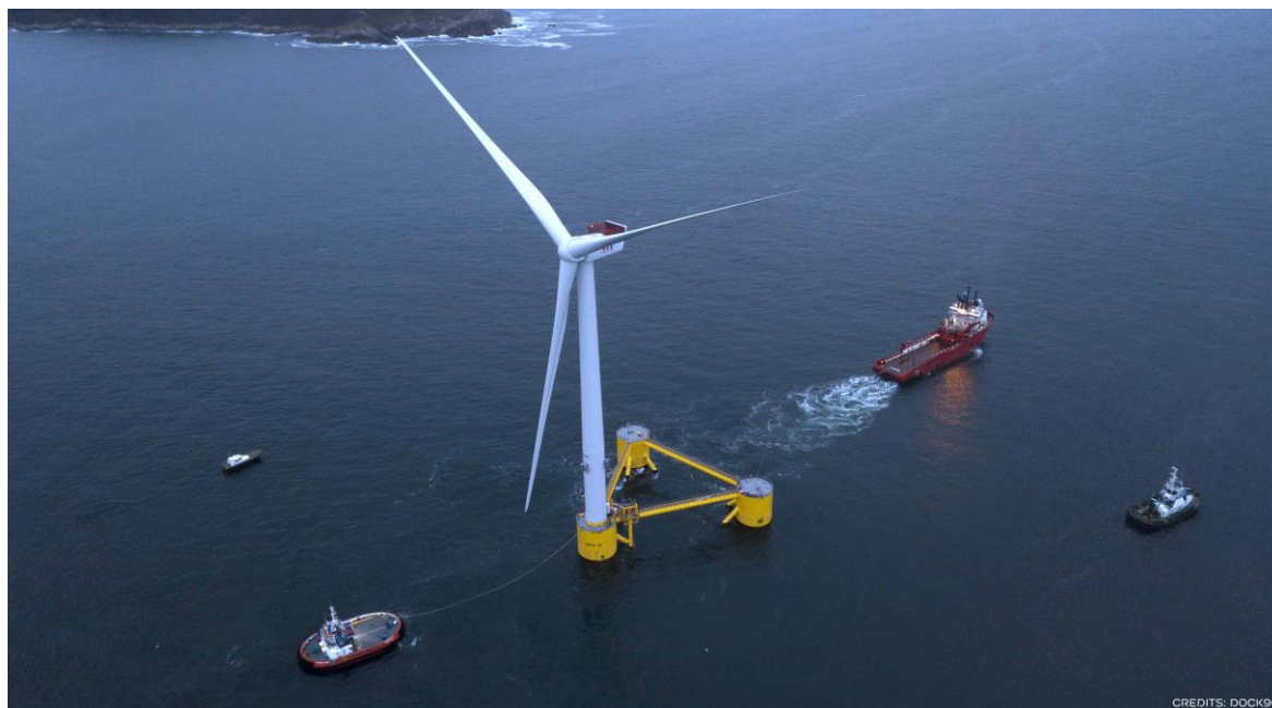
Figura 2.CC Esempio dell'operazione di rimorchio (Fonte Windfloat Atlantic Project)
