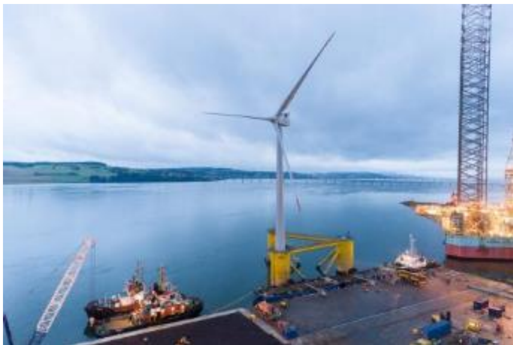
Figura 2.Y Assemblaggio piattaforma galleggiante (Fonte kinkardine -Cobra)
