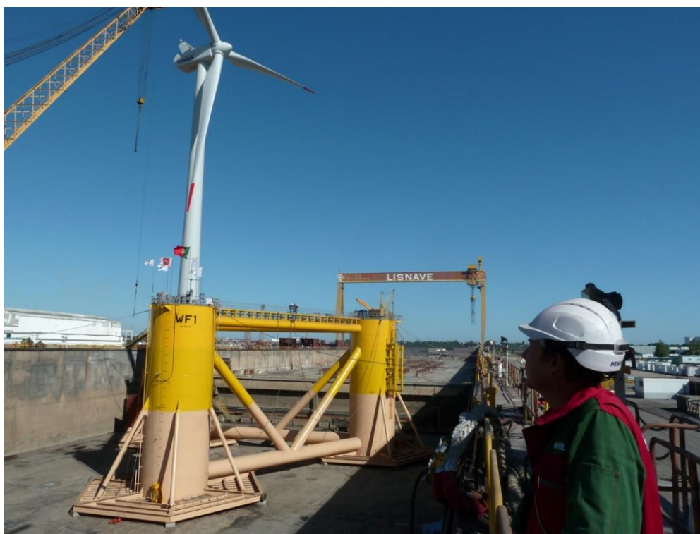
Figura 2.Z Fasi di assemblaggio della piattaforma galleggiante (Fonte Windfloat Atlantic Project)
