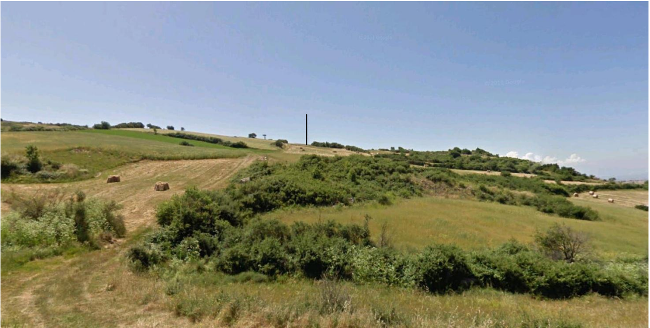
San Marco met mast SM1
