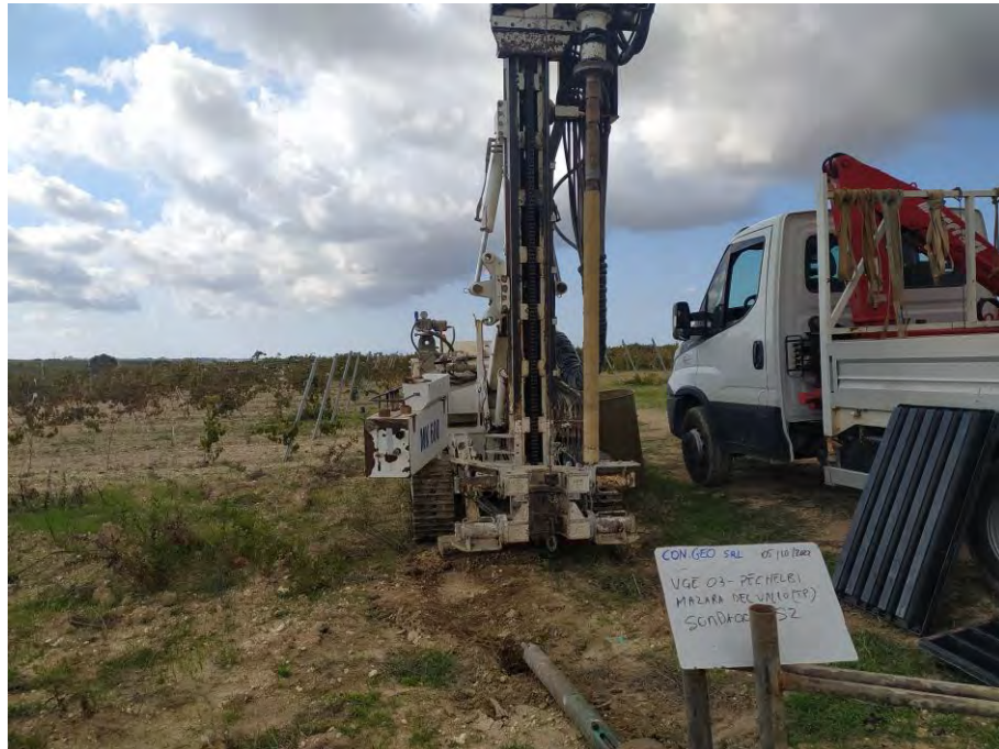
Foto n°9 – La trivella in posizione sul sondaggio S2 - CH3 (prof. 30 m).
