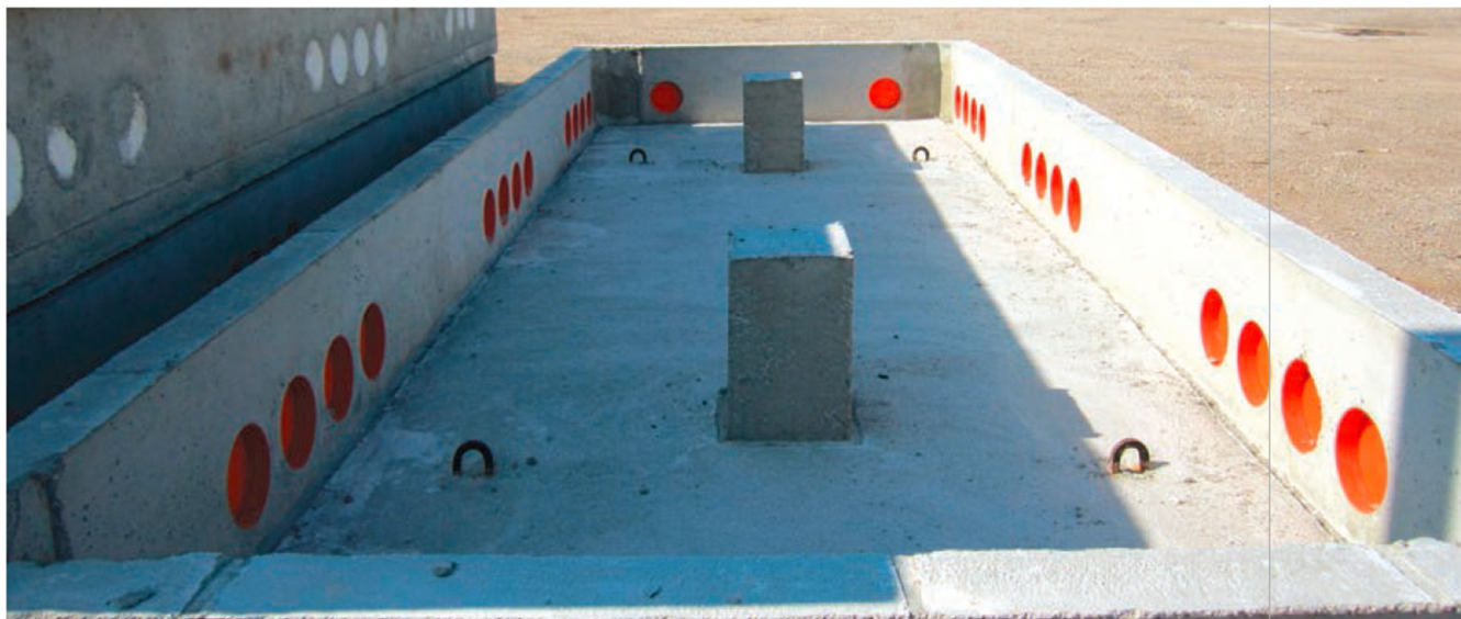
Figura 4 - Vasca di fondazione in CAV
