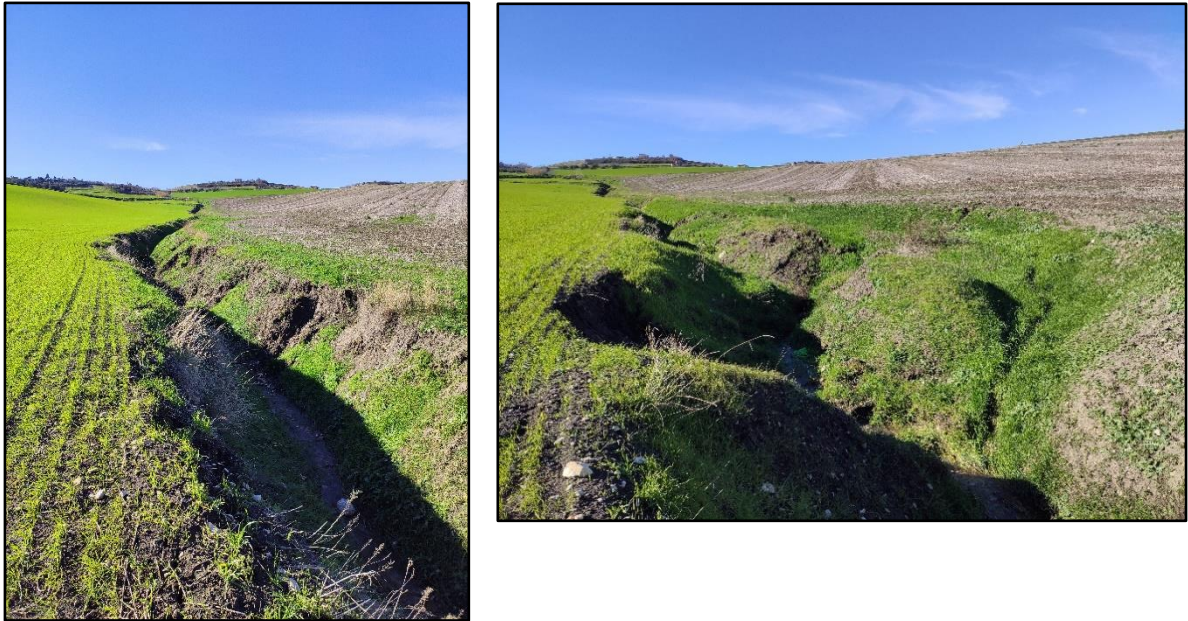
Figura 6. Dissesti lungo il fosso principale
