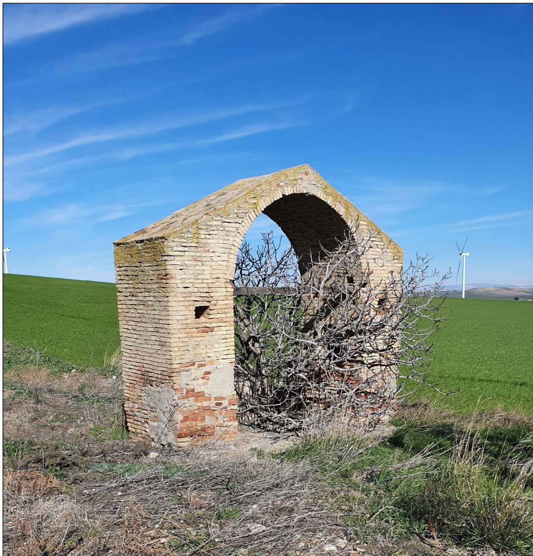
Figura 11 – Visuale frontale della costruzione ad arco
