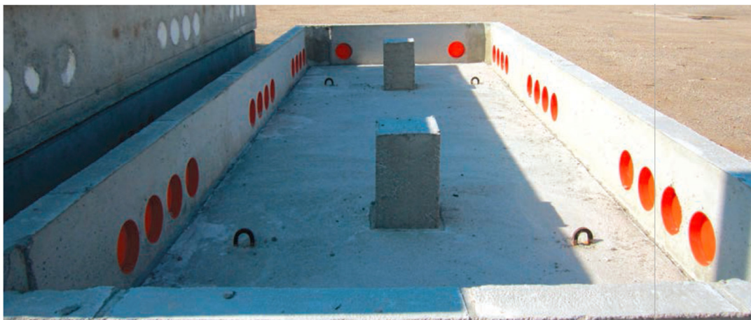
Figura 6 - Vasca di fondazione in CAV
