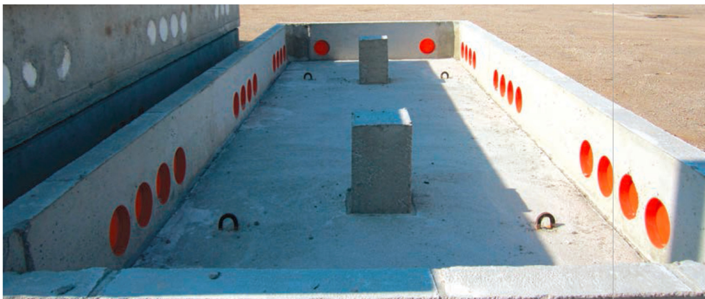
Figura 15 - Vasca di fondazione in CAV
