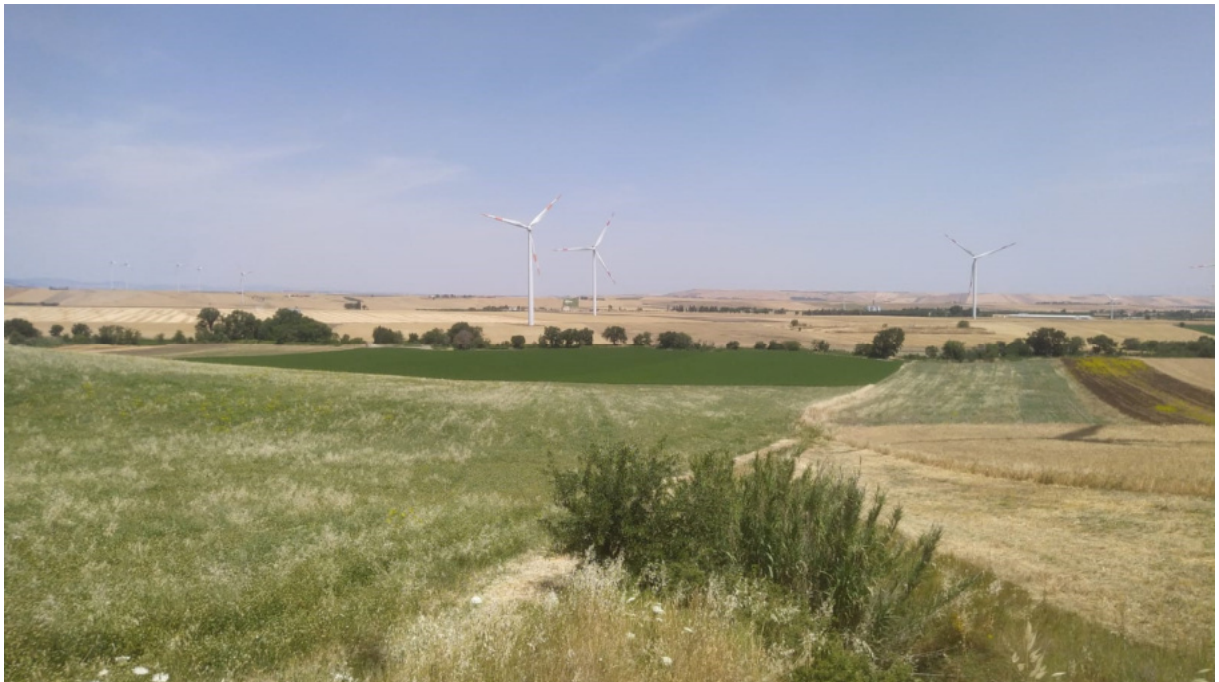
Figura 60 -Panoramica area di installazione impianto fotovoltaico
