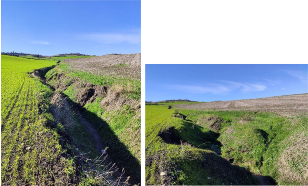
Figura 44 - Dissesti lungo il fosso principale
