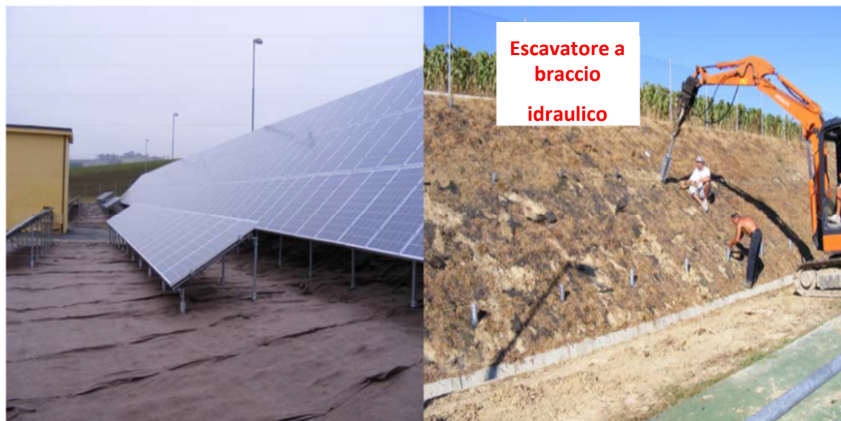
Figura 95 - Esempio di posa delle strutture portanti
