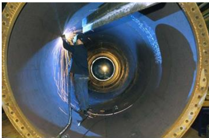
Figura 10: interno di una torre
