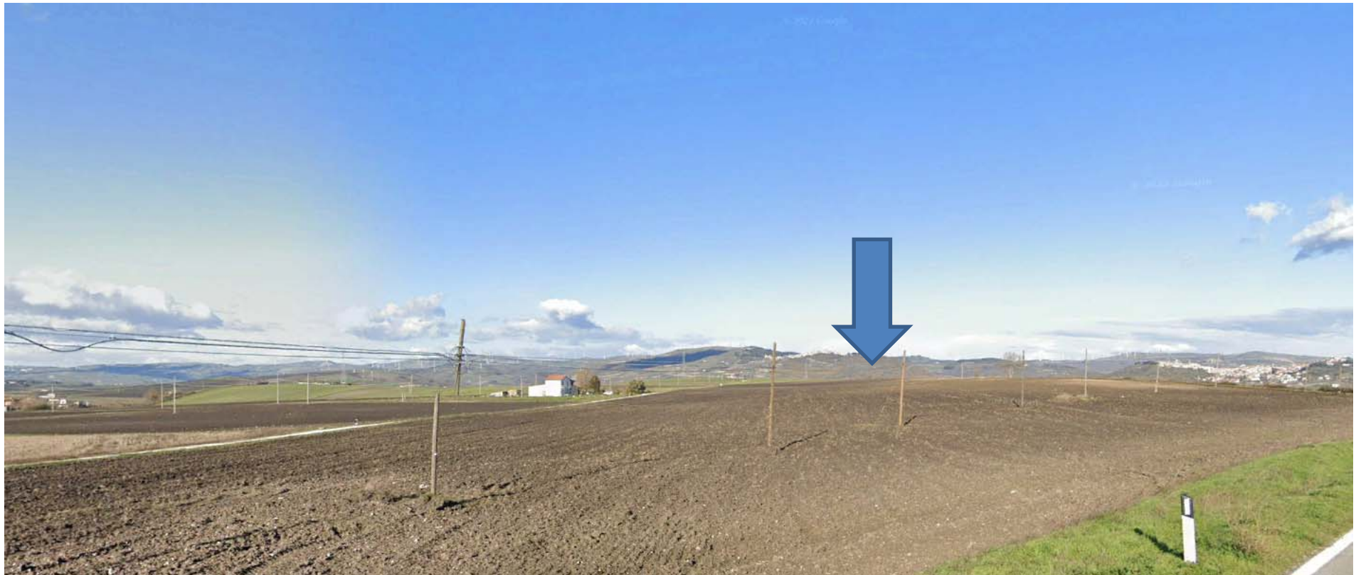
Foto 6 – turbina B07 (ripresa fotografica dalla S.S.90)
