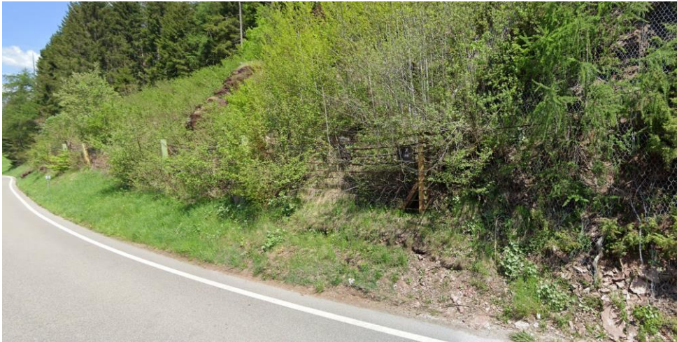
Figura 5.3 – Barriera paramassi esistente.
