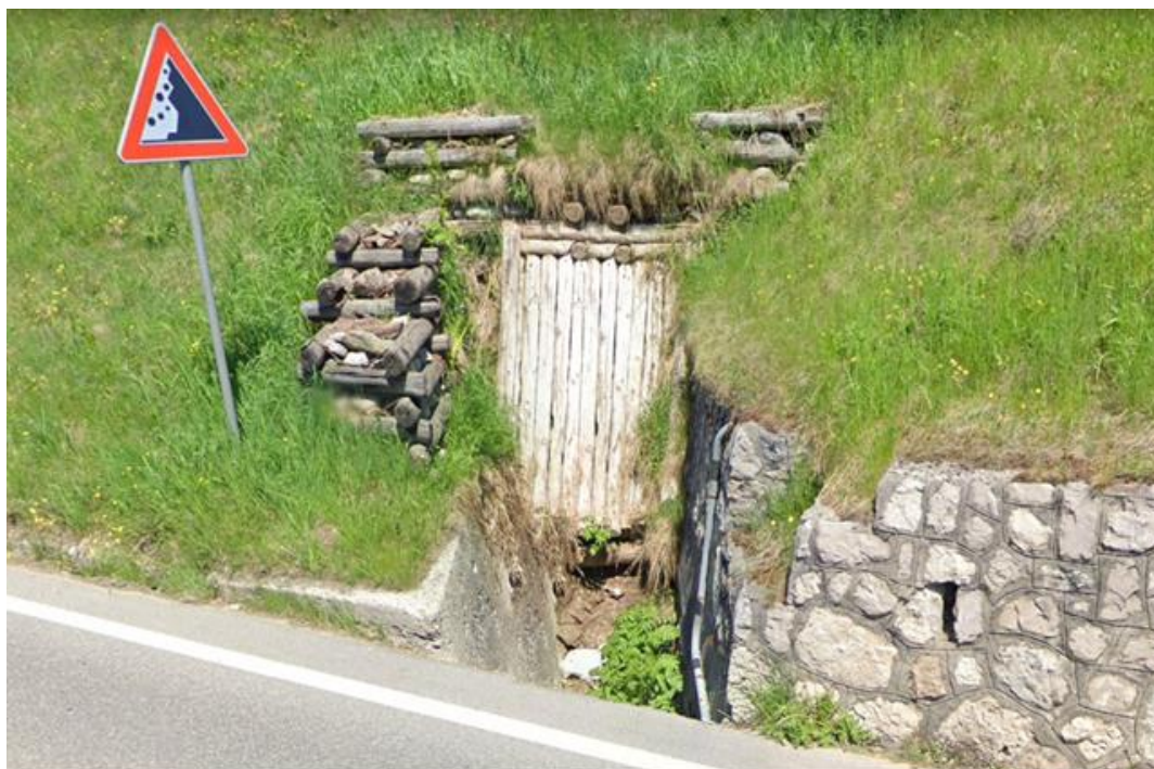
Figura 6.5 – Attraversamento T02 alla progressiva 0+322.
