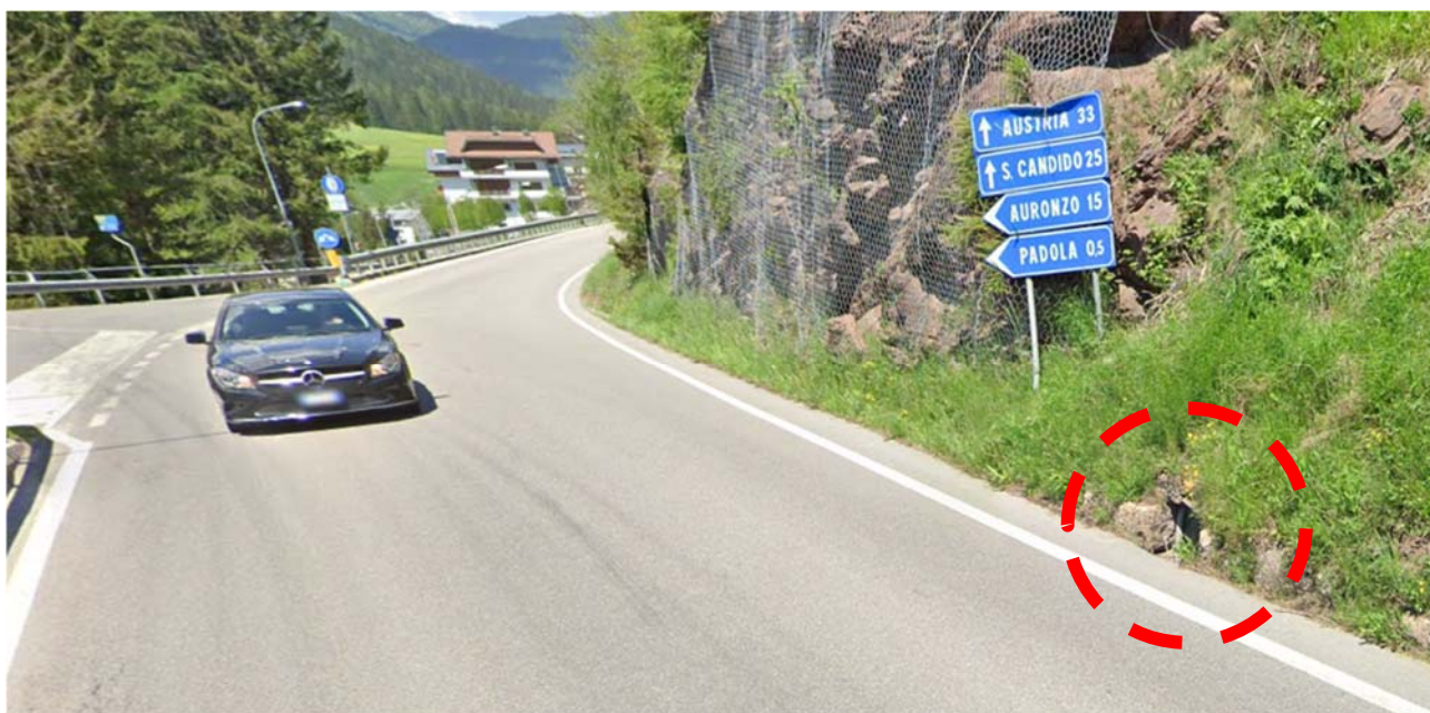
Figura 3.11 – Attraversamento T01 alla progressiva 0+116.
