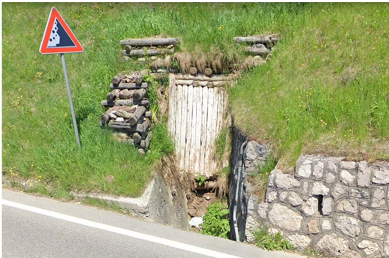
Figura 3.10 – Attraversamento T02 alla progressiva 0+322.
