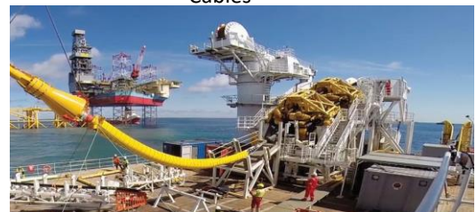
Figura 21 - Particolare dell'imbarcazione posa cavi - NKT Cables
