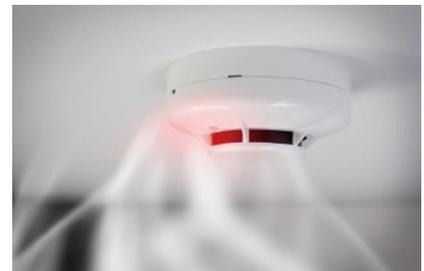
In caso di normale funzionamento del sistema, oltre ad effettuare le attivazioni di cui sopra, il rilevatore invierà alla centrale le informazioni relative alle anomalie.
