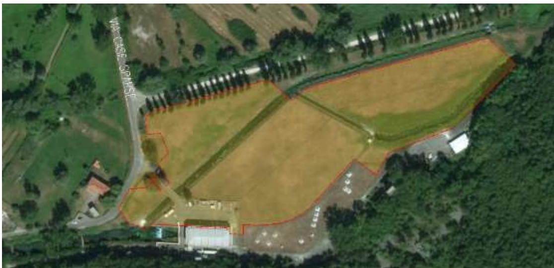
Figura 2 – Aree di cantiere Sorgenti (Piana di San Vittorino)
