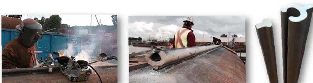
Figura 3.6 - Gargame ad omega durante la fase di saldatura lungo il fusto del lamierino.
