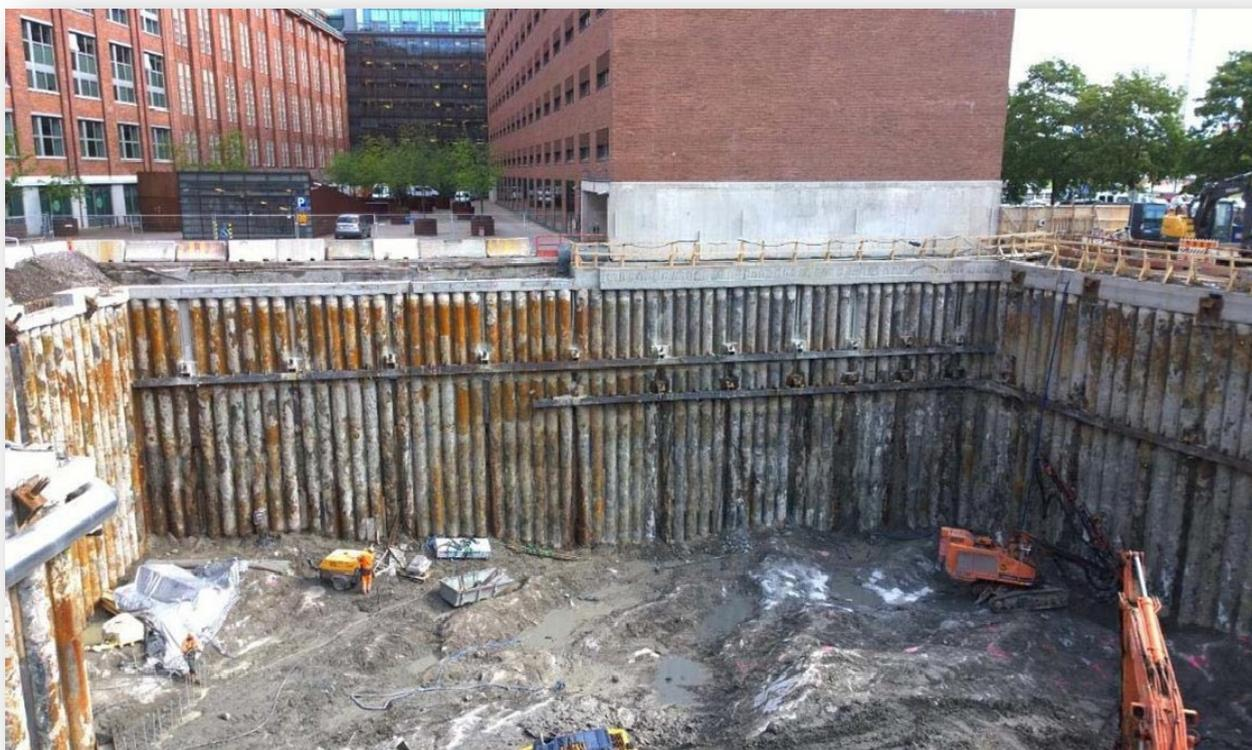
Figura 3.9 - Installazione dei pali interconnessi in un cantiere a Skanska, Helsinki
