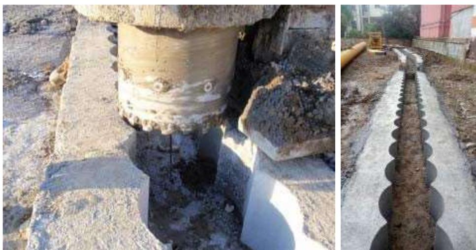
*Figura 3.3 - Esempio di correa con sagoma delle perforazioni*
