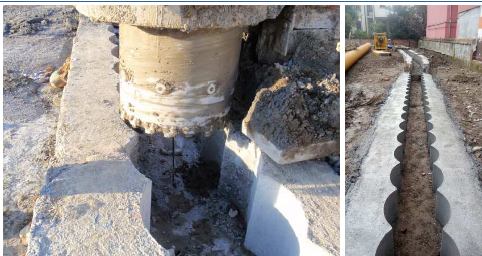
Figura 3.2 - Esempio di correa con sagoma delle perforazioni
