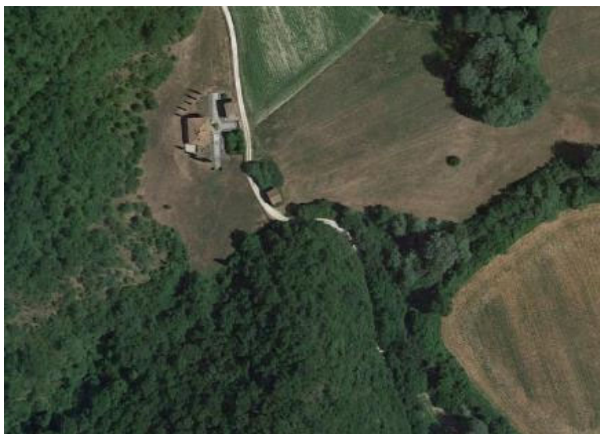
Figura 7.16 – Aree di cantiere Turano Valle
