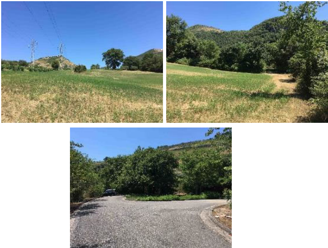
Figura 7.23 – Aree di cantiere nuovo manufatto bipartitore BIP
