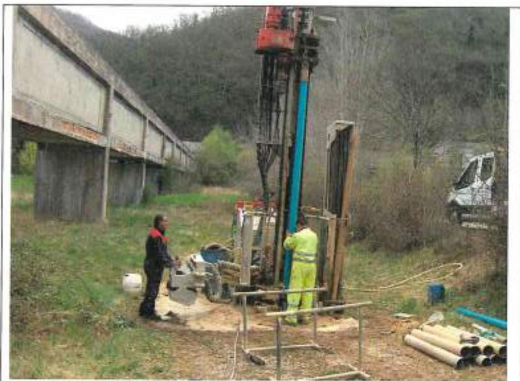
Istallazione piezometro in corrispondenza del sondaggio S7
