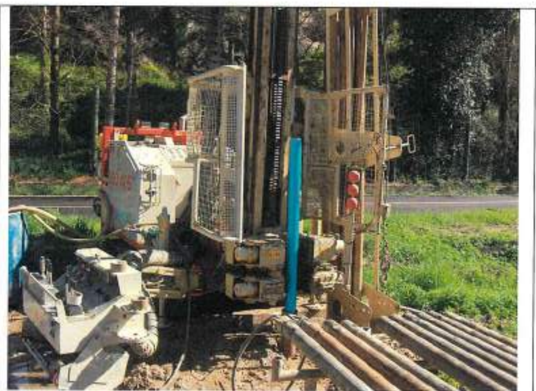
Istallazione piezometro in corrispondenza del sondaggio S3
