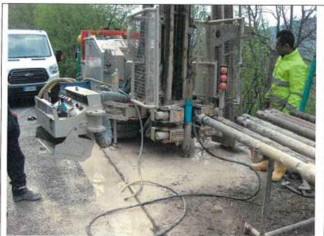
Istallazione piezometro in corrispondenza del sondaggio S1
