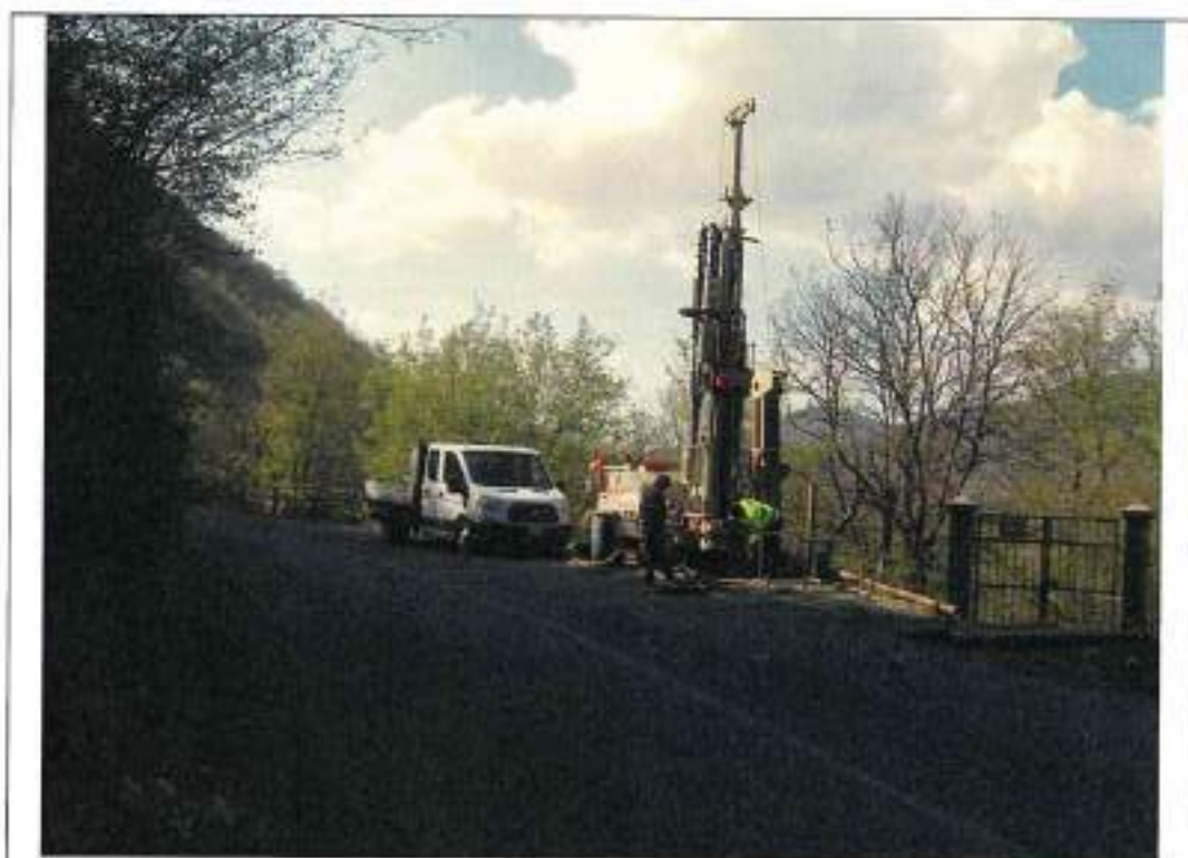
Esecuzione sondaggio S1
