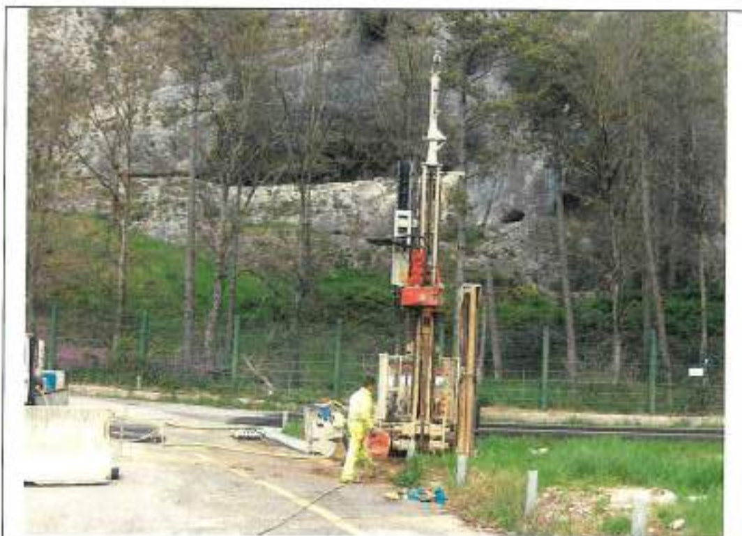
Postazione ed Esecuzione sondaggio S3
