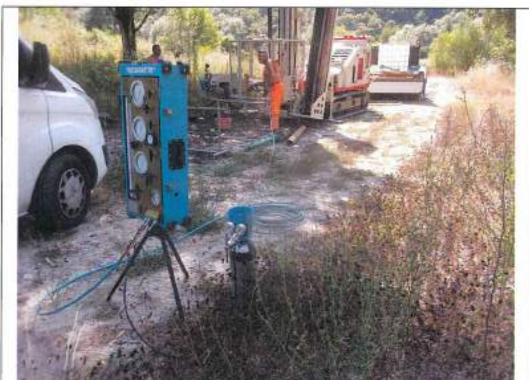
Esecuzione prove pressiometriche in sondaggio S6
