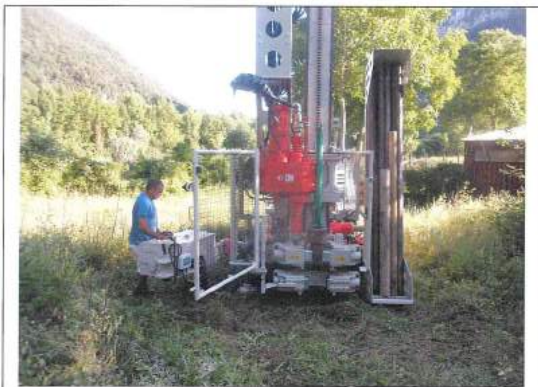
Postazione ed Esecuzione sondaggio S4
