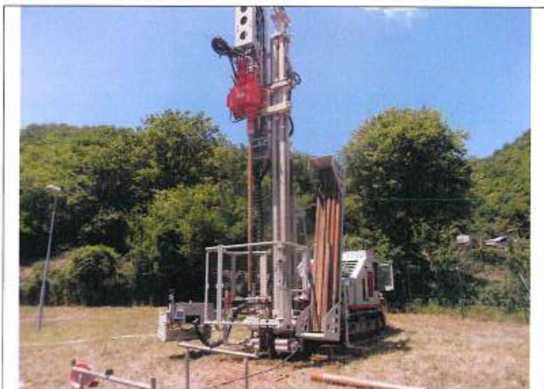
Esecuzione sondaggio S10 (2)
