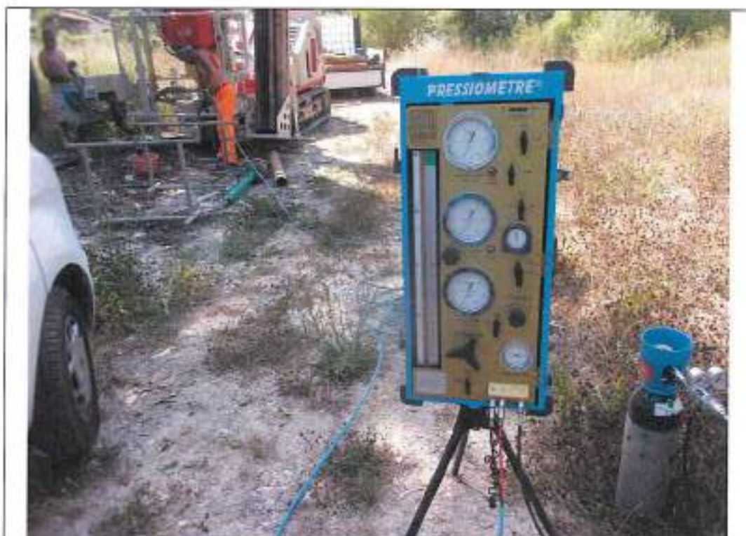
Esecuzione prove pressiometriche in sondaggio S6
