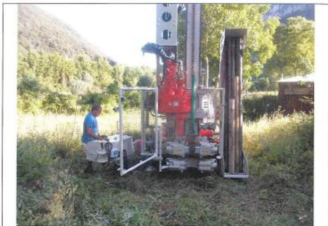
Esecuzione prova SPT in sondaggio S41
