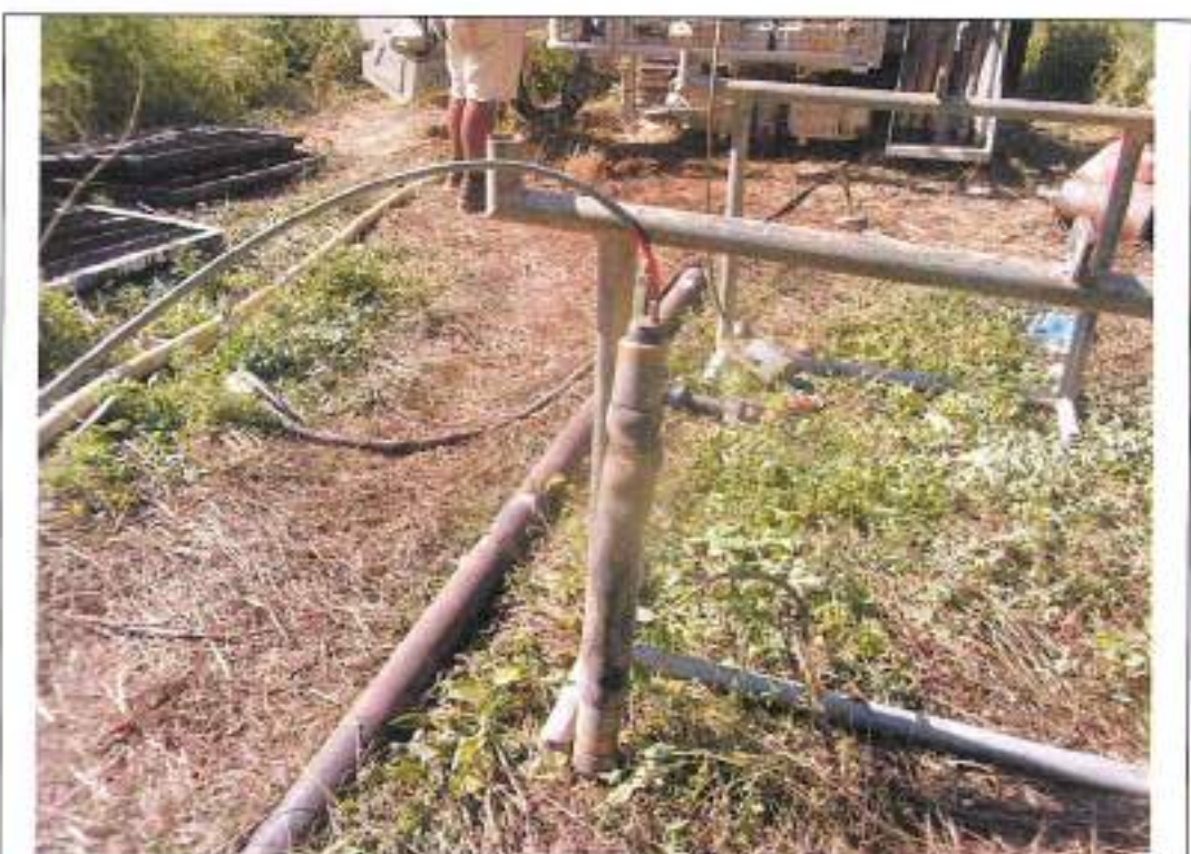
Esecuzione prove pressiometriche in sondaggio S4
