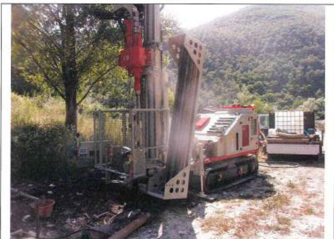
Esecuzione sondaggio S6
