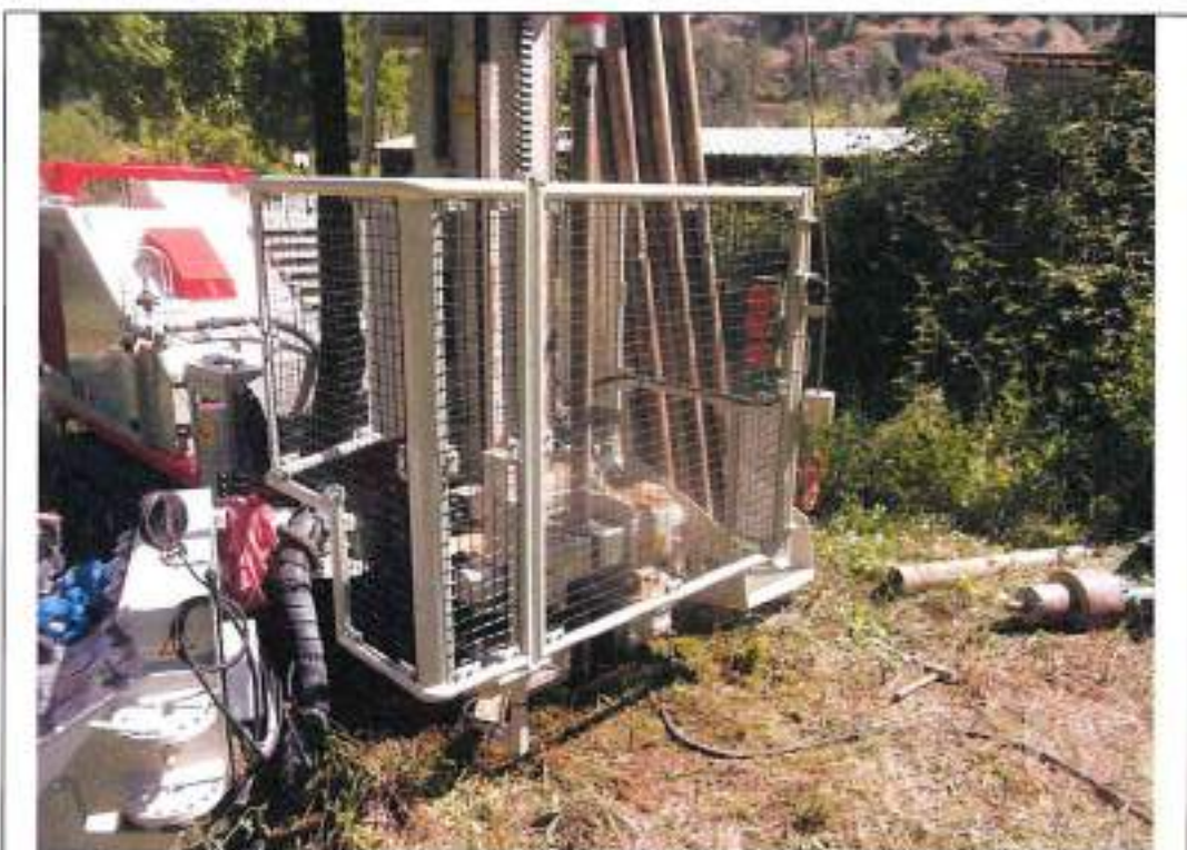
Esecuzione sondaggio S4
