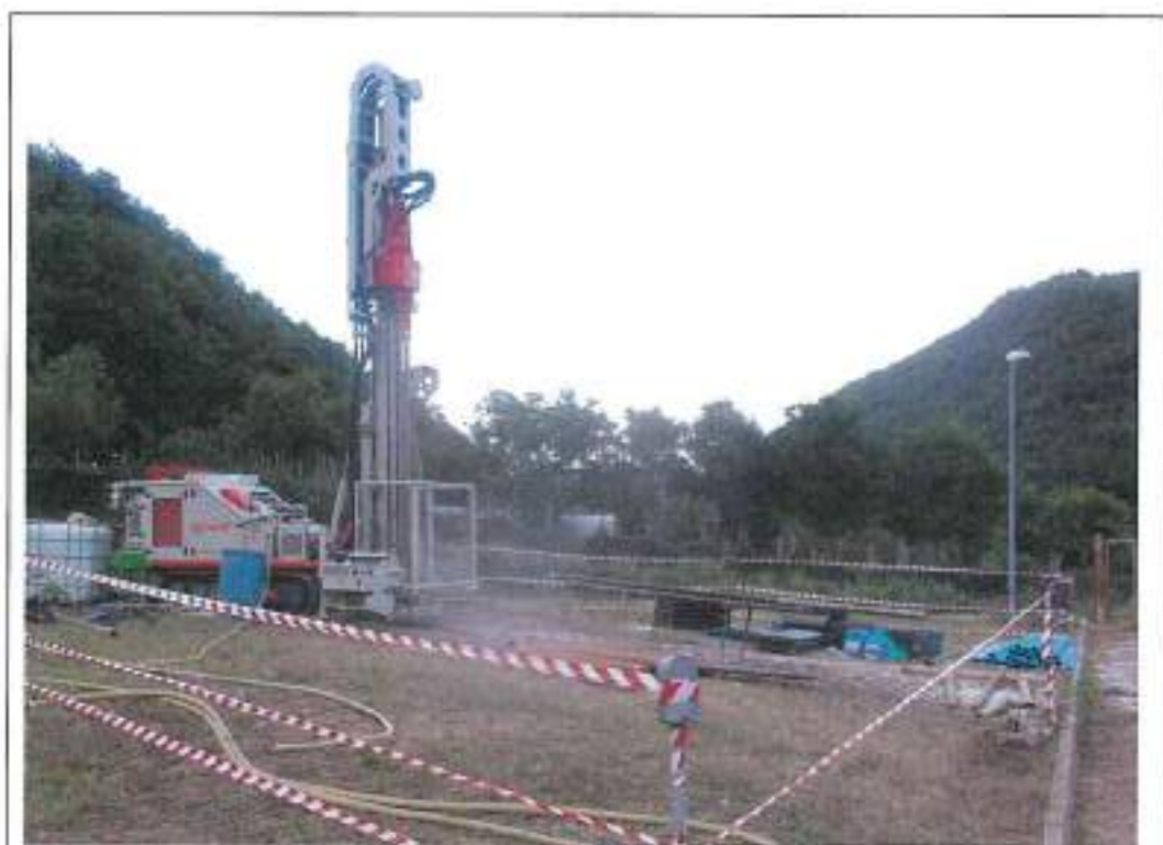
Tubi piezometrici in corrispondenza del sondaggio S10
