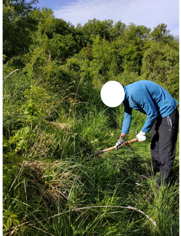
Energizzazione con mazza battente
