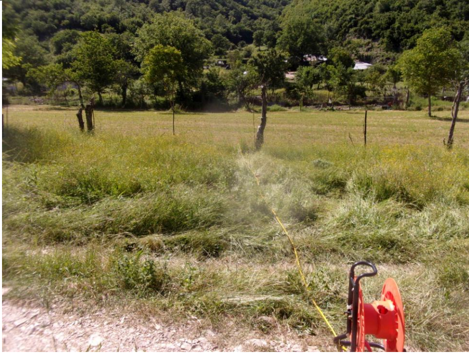
Esecuzione profilo geoelettrico 1-1'
