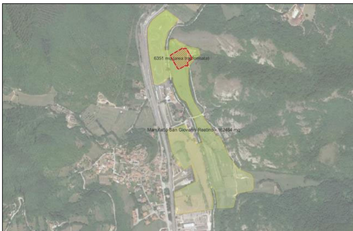
Fig. 48: Area di intervento e superfici trasformate presso le opere di San Giovanni Reatino (Google Maps)
