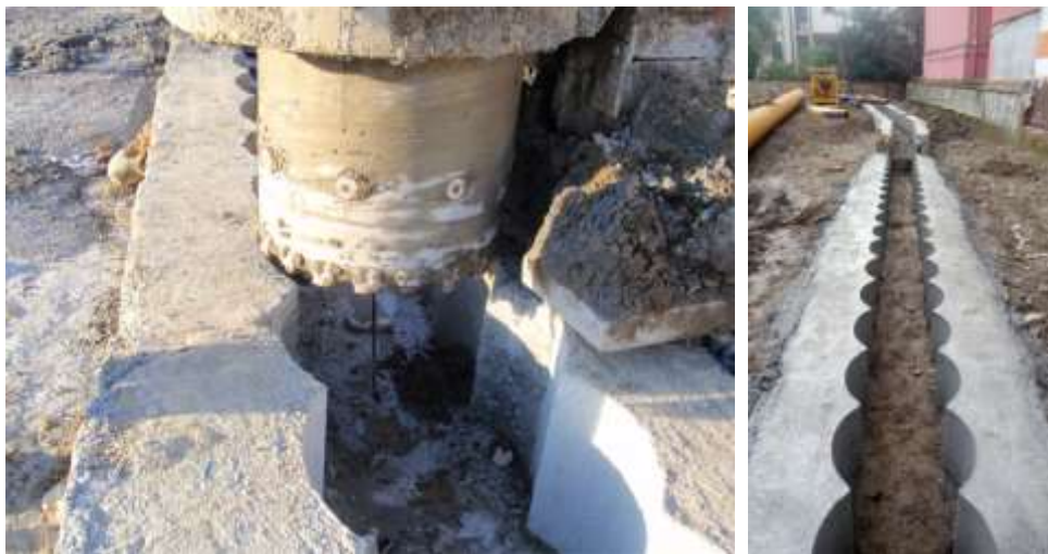
Figura 3.3 - Esempio di correa con sagoma delle perforazioni
