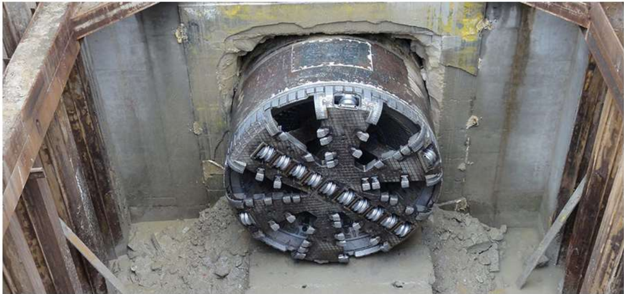
Figura 5.10 – Esempio di testa fresante per scavo di materiali misti.
