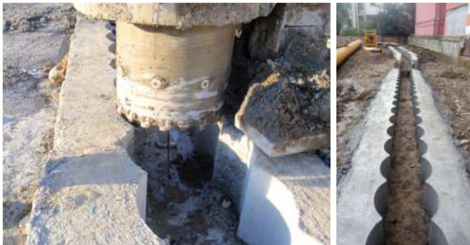
**Figura 4.4 - Esempio di correa con sagoma delle perforazioni**
