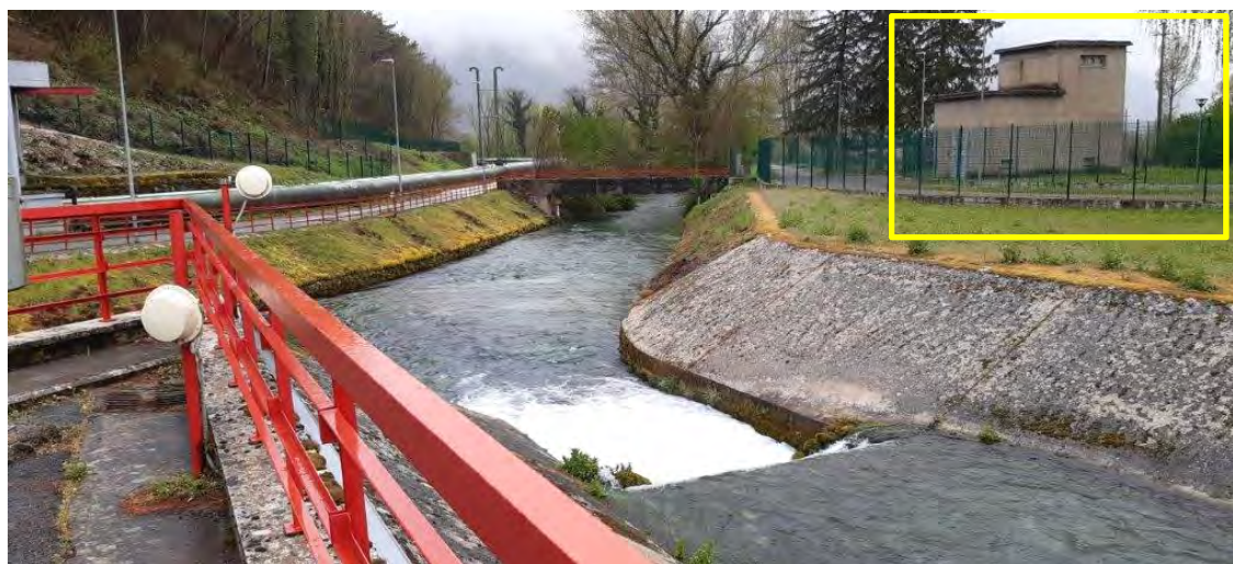
Figura 6.1 – Aree di cantiere Sorgenti – Cabina Elettrica
