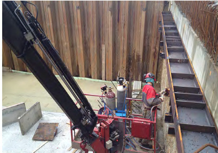
Figura 10.11 – Esempio realizzazione mensole e trave di ripartizione
