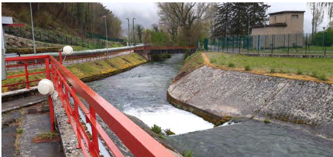
Figura 6.5 – Aree di cantiere Sorgenti – Alveo Rio Peschiera
