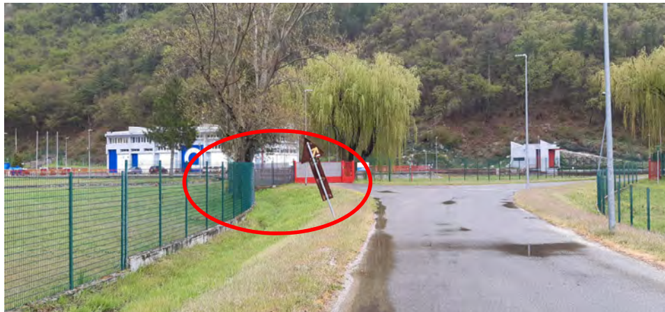
Figura 6.13 – Punto in cui è previsto l’accesso all’area di cantiere
