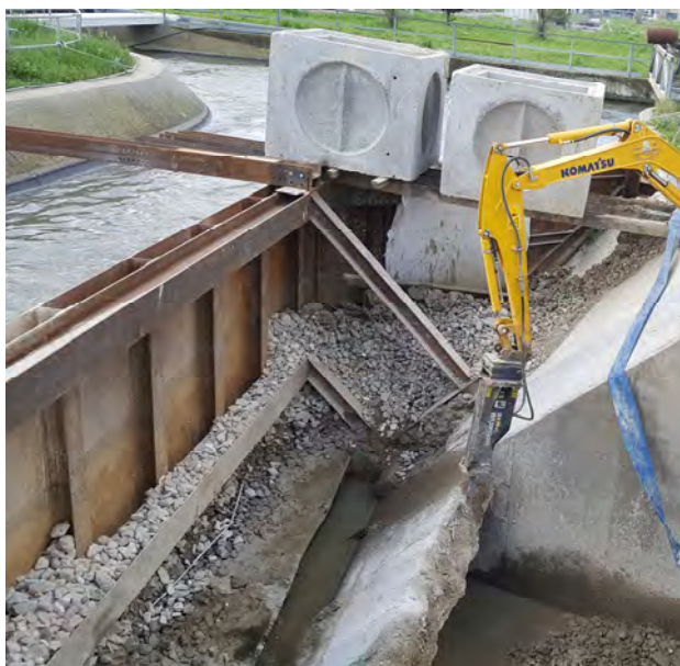
Figura 10.4 – Esempio di sbarramento metallico per realizzazione canale di collegamento
