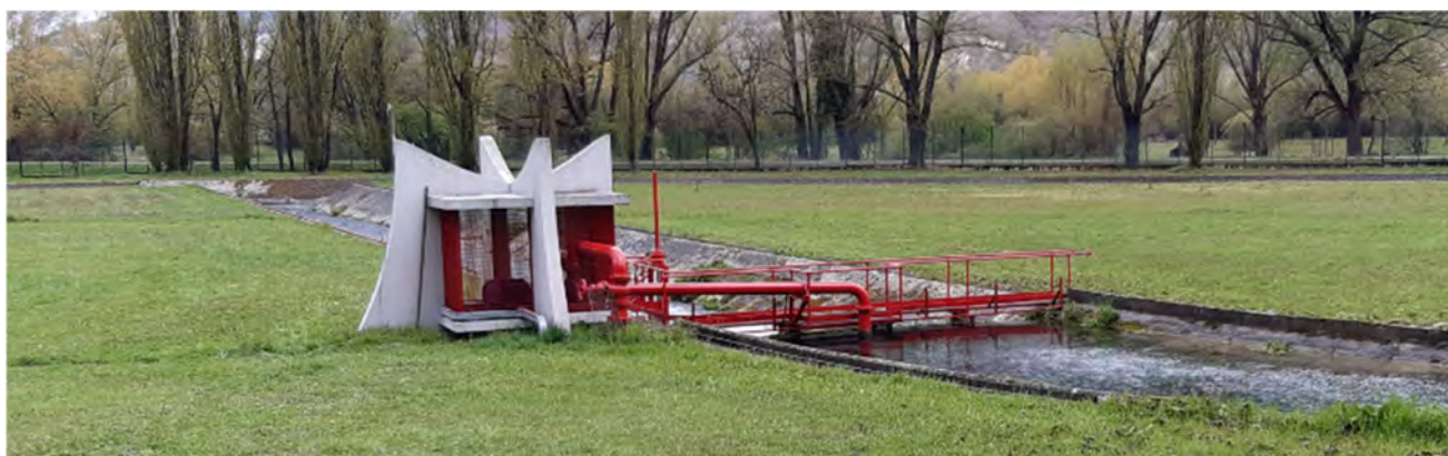
Figura 10.5 – Impianto di sollevamento esistente da demolire
