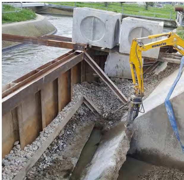
Figura 10.16 – Esempio di sbarramento metallico per realizzazione canale di collegamento
