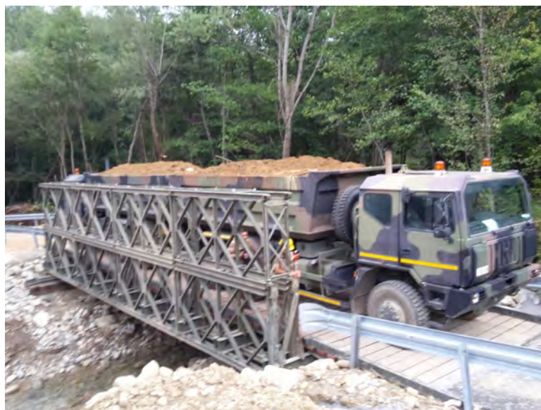
Figura 7.5 – Aree di cantiere Sorgenti (Piana di San Vittorino) – Ponte Bailey
