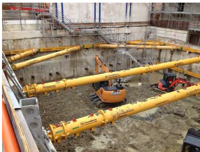
Figura 10.10 – Esempio puntoni metallici
