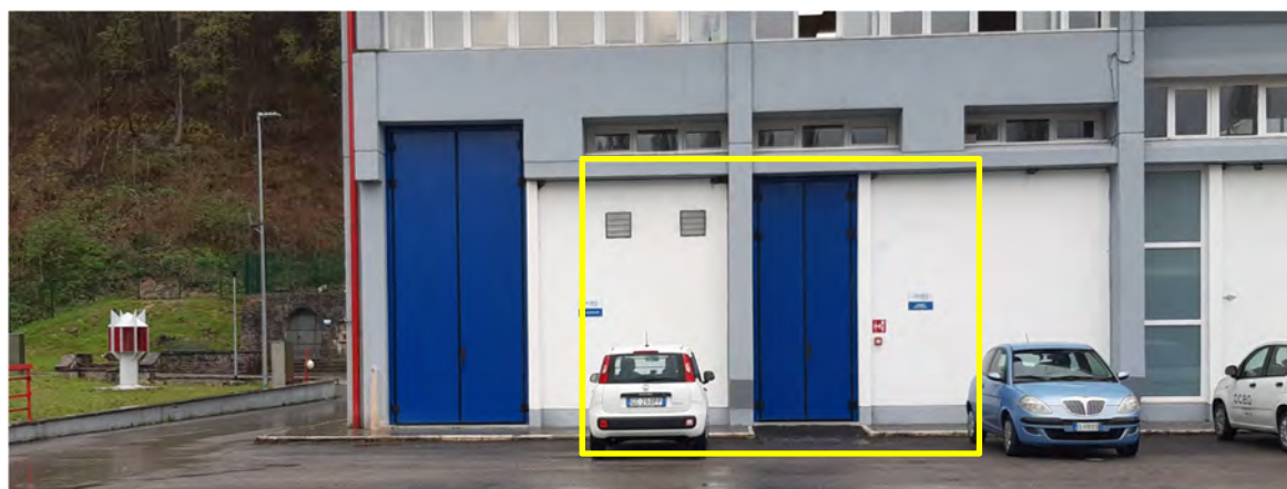
Figura 6.2 – Aree di cantiere Sorgenti – Cabina Elettrica
