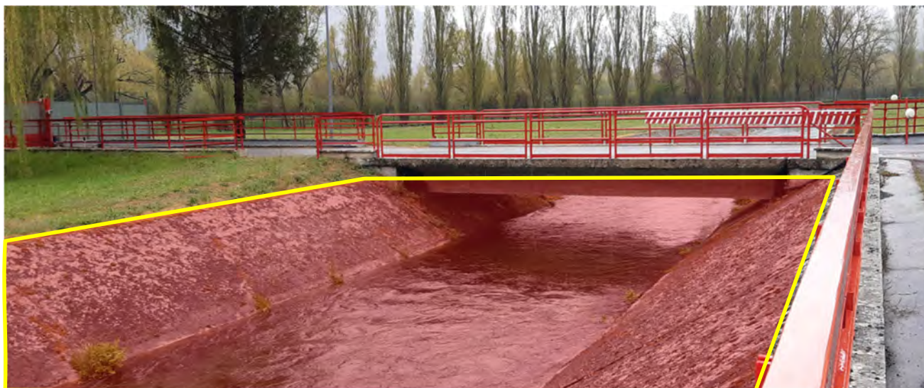
Figura 10.15 – Tratto di canale in uscita oggetto di intervento
