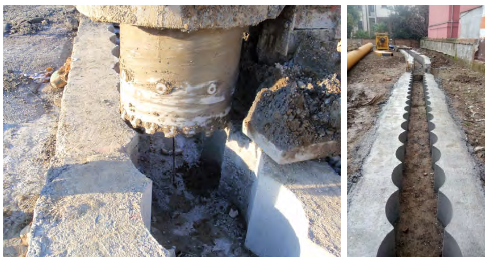
Figura 10.8- Esempio di correa con sagoma delle perforazioni
